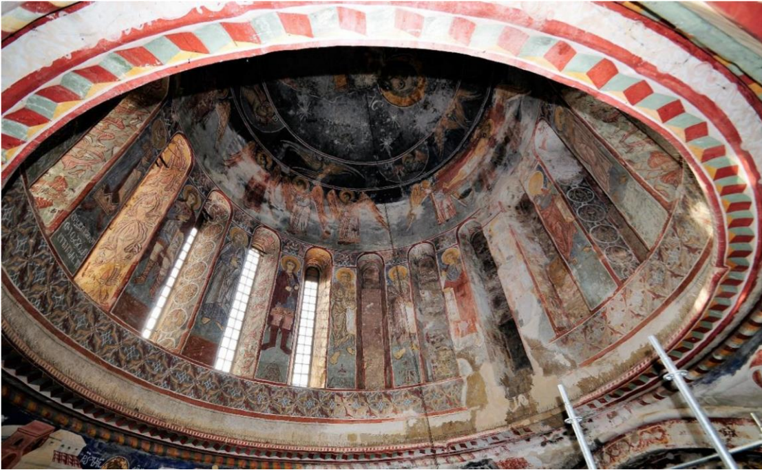
ფოტო 1. საყრდენი კედელი აქტიური ნესტის აშკარა ნიშნებით. ამოშენებული სარკმლის ღიობები გუმბათის ყელის დასავლეთ მხარეს.
