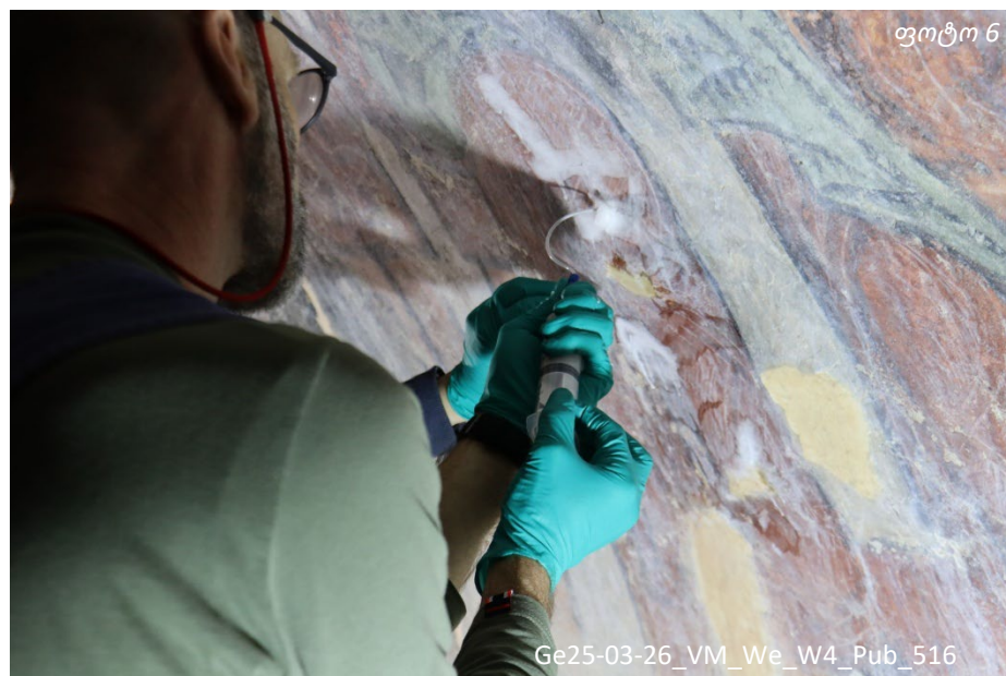
ზემოთ ფოტოებზე ასახულია: 5. წინასწარი დასველება. 6. ჩასხმის პროცესი შპრიცისა და კათეტერის გამოყენებით; ნართექსი, მარტი-აპრილი, 2025.
