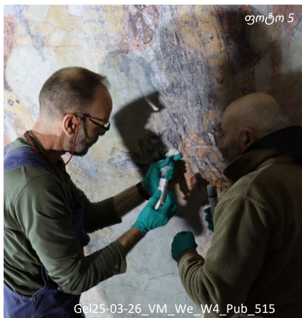
ზემოთ ფოტოებზე ასახულია: 5. წინასწარი დასველება. 6. ჩასხმის პროცესი შპრიცისა და კათეტერის გამოყენებით; ნართექსი, მარტი-აპრილი, 2025.
