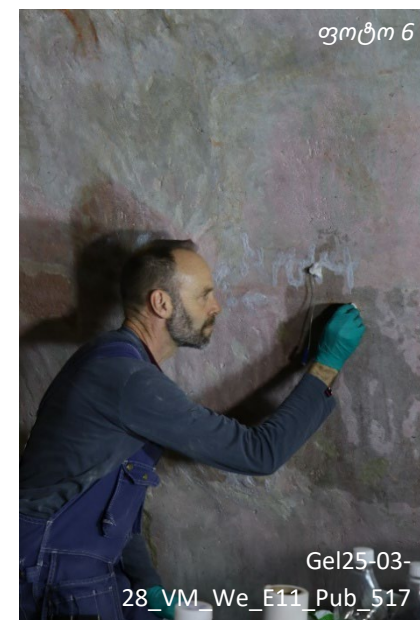
ზემოთ ფოტოებზე ასახულია: 5. წინასწარი დასველება. 6. ჩასხმის პროცესი შპრიცისა და კათეტერის გამოყენებით; ნართექსი, მარტი-აპრილი, 2025.
