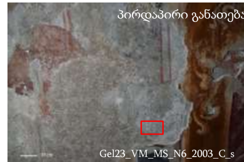
მარჯვნივ: მაკრო ფოტო, ადრეული მხატვრობის ნალესობის ფენის სტრატეგრაფია. 0 - ქვის საფუძველი 1 - ძირითადი ნალესობა 2 - მოსამზადებელი ფენა.
