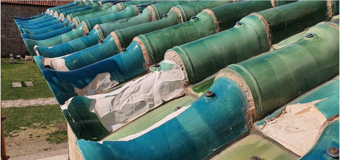
სურ. 1. დაზიანებული კრამიტის ფრაგმენტი
