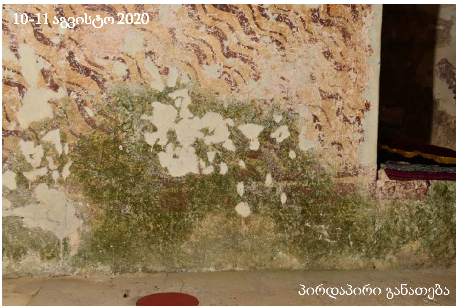
დასავლეთი კედელი, ქვედა დონე, მწვანე ბიოლოგიური პატინა
