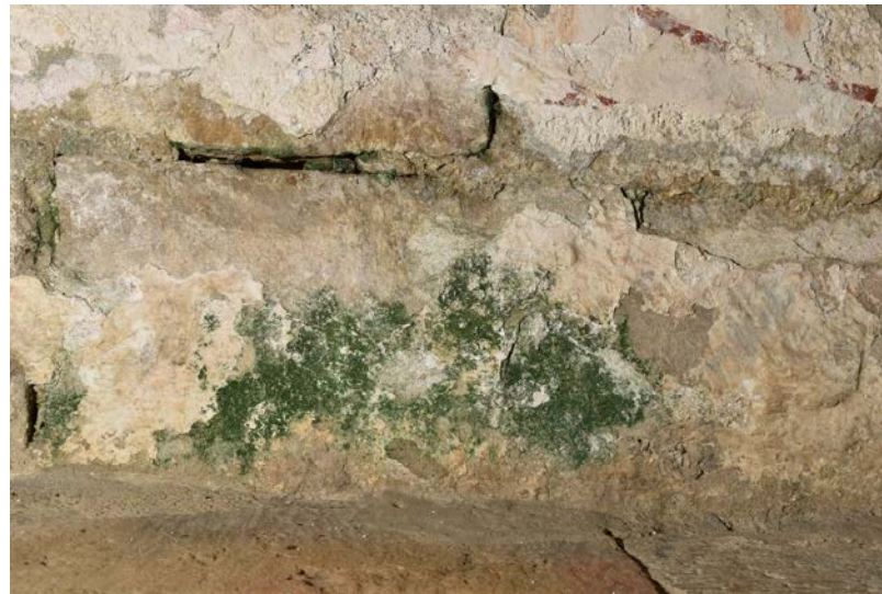
ეკლესიის ინტერიერი: ჩრდილოეთ კედელზე არსებული მწვანე ფერის ბიოლოგიური დაზიანების მაგალითი.
