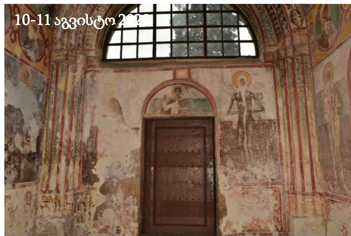
ჩრდილო-აღმოსავლეთი კუთხე, ქვედა დონე, მწვანე ბიოლოგიური პატინა
