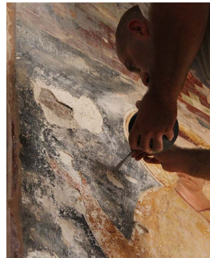
სამხრეთი კედელი, ინტერიერი. მხატვრობის არასტაბილური არეების დროებითად გამაგრების პროცესი.
