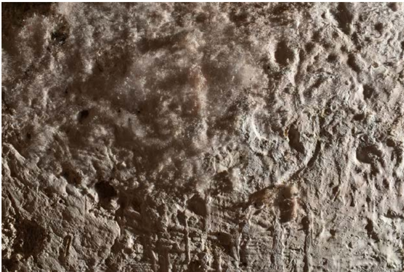
ეკლესიის ინტერიერი: ჩრდილოეთ კედელზე არსებული სქელი, ფაფუკი გამომარილების მაგალითი.
