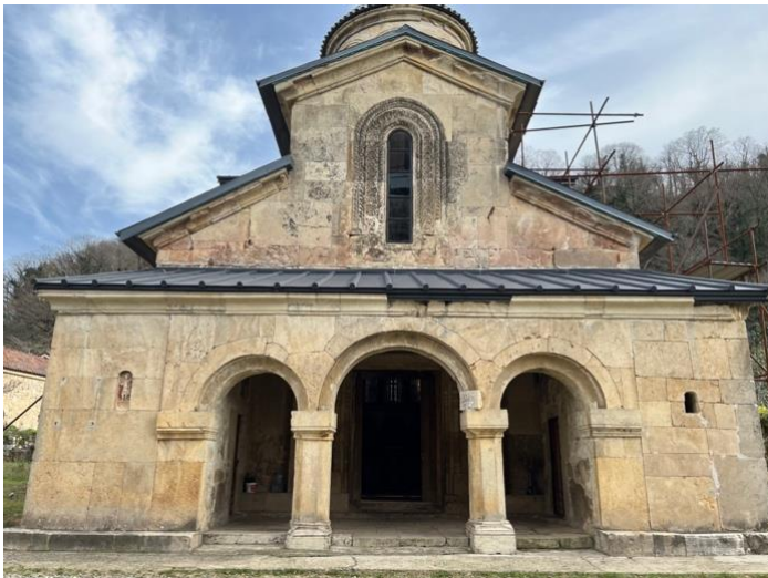
სურ. 58, 59. წმინდა გიორგის ეკლესიის ფასადის ხედი: წყობის ნაკერებში შემავსებლის საჭიროება წყლის შეღწევის თავიდან ასაცილებლად.
