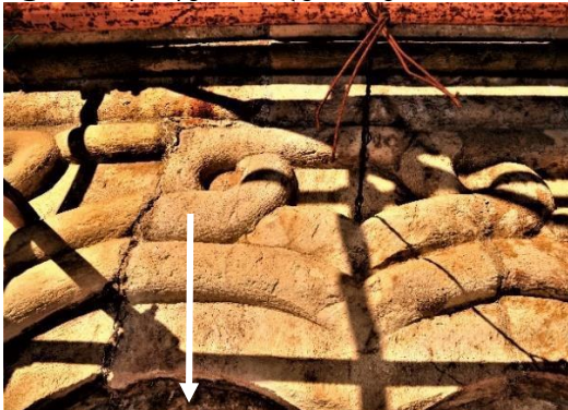
სურ. 44. დასავლეთი მკლავი – სამხრეთი ფასადი: სტრუქტურულ – დეკორატიული თლილი ქვების გადანაცვლება.
