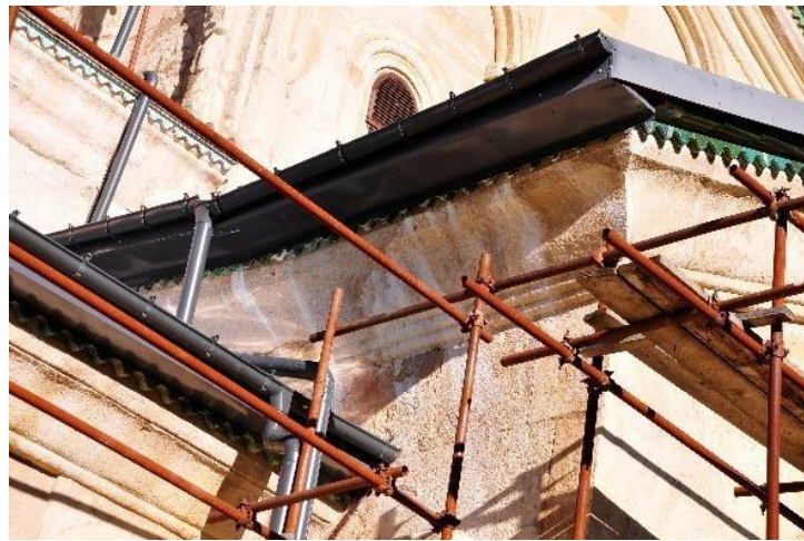
სურ. 16. გუმბათის ყელის საფუძველი: ორიგინალური ქვა უფრო მეტად გამოჩეულია, ვიდრე ახლად დამატებული
