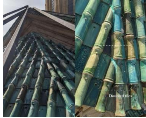
სურ. 14. წმინდა გიორგის გუმბათი. სპეციალური კრამიტი აშკარად ჩანს (ფოტო მოწოდებულია)
