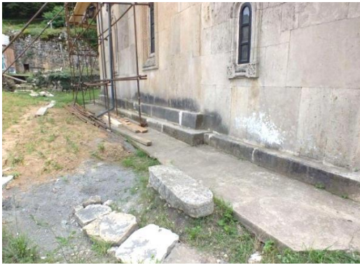
სურ. 61. წმინდა გიორგი: გარე ხედი, ჩრდილოეთის მხარე. ხილული აღმავალი/მზარდი ტენიანობის დეტალი (ReStruere-ის მიერ)
