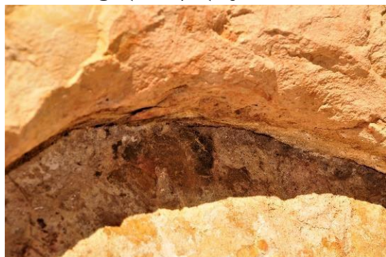
სურ. 44. დასავლეთი მკლავი – სამხრეთი ფასადი: სტრუქტურულ – დეკორატიული თლილი ქვების გადანაცვლება.
