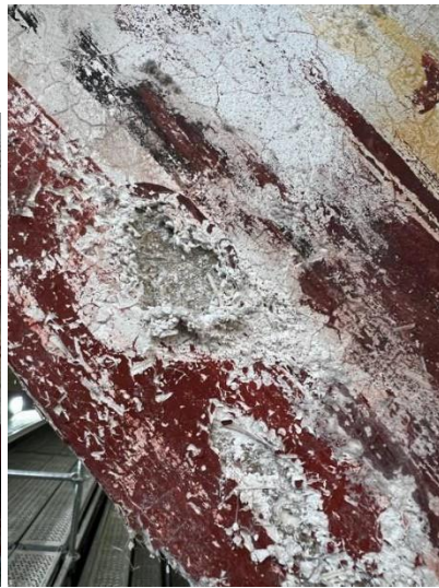
სურ.32,33. ჩრდილო-დასავლეთ აფრა ქვეშ ბათქაშის ძლიერი დეგრადაციის უბნები
