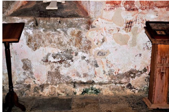
სურ. 61. წმინდა გიორგი: გარე ხედი, ჩრდილოეთის მხარე. ხილული აღმავალი/მზარდი ტენიანობის დეტალი (ReStruere-ის მიერ)
