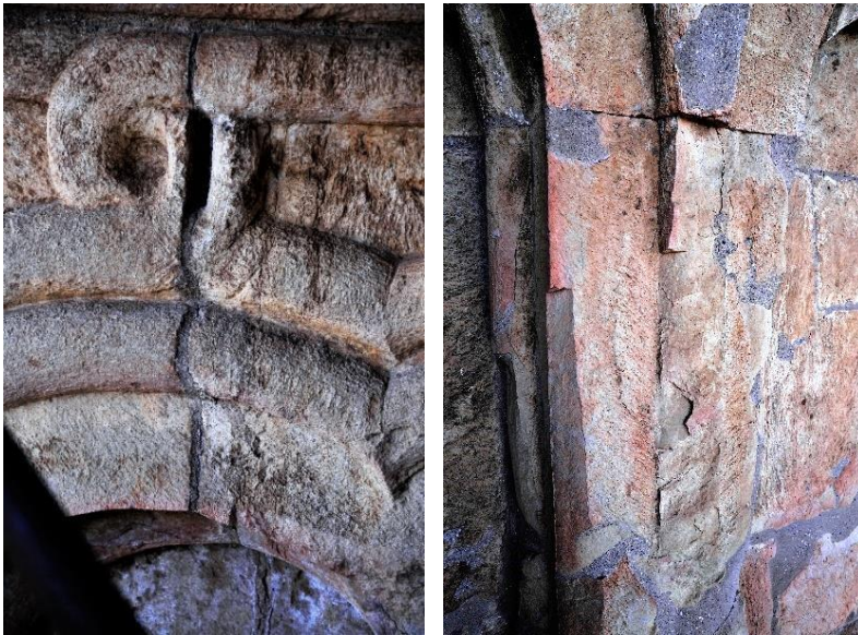
სურ. 53, 54. ჩრდილოეთ მკლავი – დასავლეთის ფასადი: ნაკერების ღია ზზარები, ქსოვილის განშრევება და მარილების კრისტალიზაცია.
