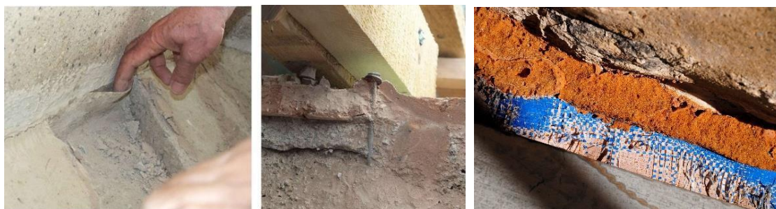
სურ. 12. არასწორი ინსტალაციის ტექნიკა: საიზოლაციო მასალის მოკლე ზოლი/ლურსმნები, რომლებიც თხევად საიზოლაციო ხსნარში აღწევს (ReStruere-ის მიერ მოწოდებული)
