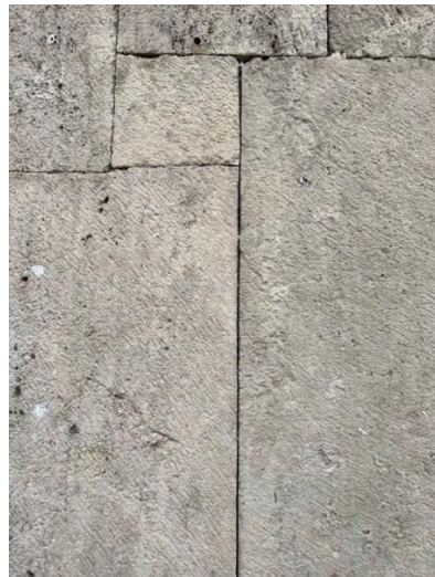
სურ. 58, 59. წმინდა გიორგის ეკლესიის ფასადის ხედი: წყობის ნაკერებში შემავსებლის საჭიროება წყლის შეღწევის თავიდან ასაცილებლად.
