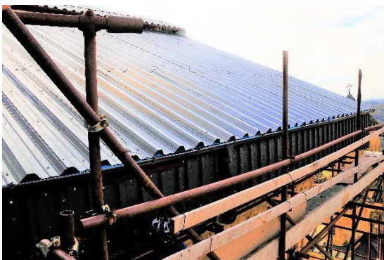
სურ. 20. დასავლეთ მკლავის სამხრეთი კედელი. გრძივი ზხარი კედლის თავზე (ReStruere) სურ. 21. დასავლეთ მკლავი, ახალი დროებითი გადახურვა ნახ. 22. ლიობები, რომლებიც ჰაერს ცირკულირების საშუალებას აძლევს და ხელს უწყობს ტენიანობის აორთქლებას დასავლეთ მკლავი კამარის თავზე.
