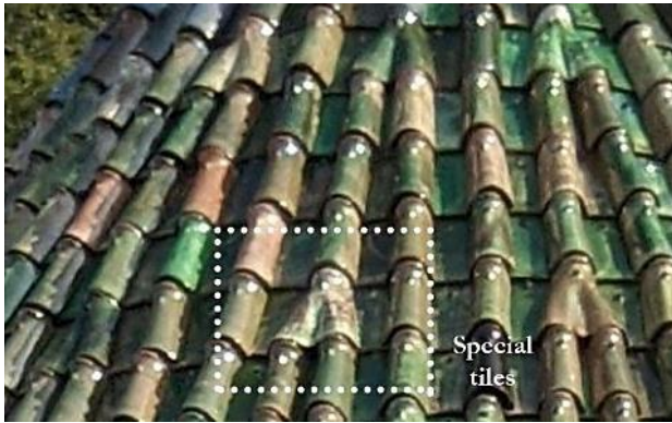
სურ. 14. წმინდა გიორგის გუმბათი. სპეციალური კრამიტი აშკარად ჩანს (ფოტო მოწოდებულია)
