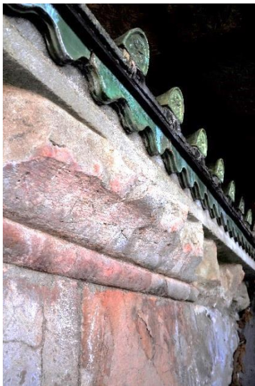
სურ. 16. გუმბათის ყელის საფუძველი: ორიგინალური ქვა უფრო მეტად გამოჩეულია, ვიდრე ახლად დამატებული
