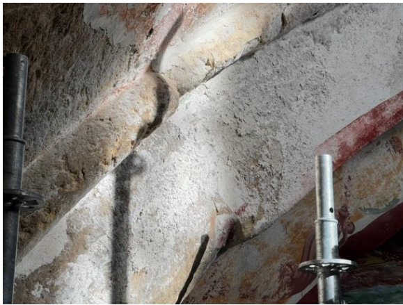
სურ.32,33. ჩრდილო-დასავლეთ აფრა ქვეშ ბათქაშის ძლიერი დეგრადაციის უბნები
