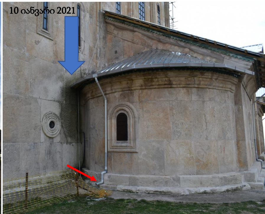
ჩრდილო-აღმოსავლეთი ეკვდერის საკურთხევლის დროებითი გადახურვა, სამხრეთ ნაწილში ძალიან დახრილია და ჟოლობები სრულად ვერ კრებენ წყალს, შესაბამისად ხდება ფასადის წყლის მიერ დასველება და ქვისა და შევსებების დაზიანება.
