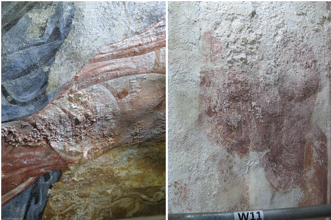
Fig. 3, 4. მხატვრობის აქერცლილი, განშრევებული, გაფხვიერებული ფენა
