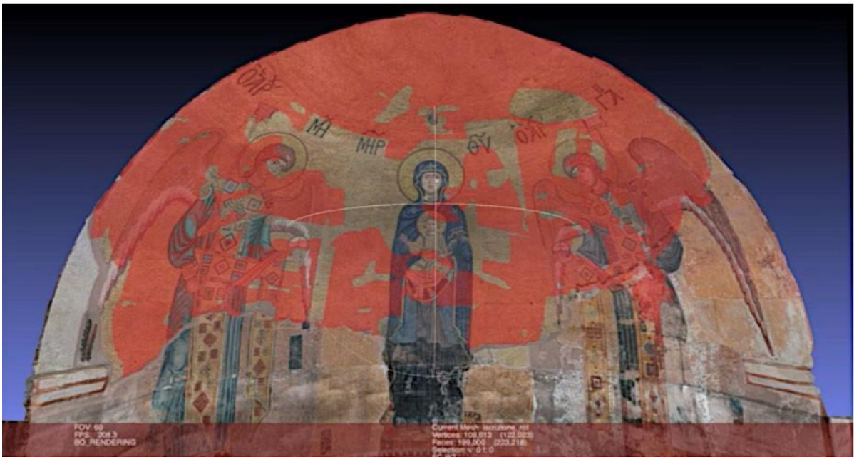
Fig. 6. დაზიანებათა რუკა, რომელიც ასახავს მოზაიკური კომპოზიციის 85%-ის კედლიდან მოშორებას (რობერტო ნარდის ანგარიში, 2024 წლის 24 ივლისი)
