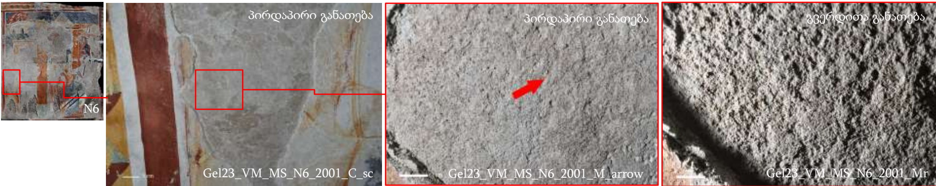
ზემოთ: დასავლეთი მკლავის ჩრდილოეთი კედელი (N6). ქვემოთ: მიკრო ფოტოები, უფერწერო ნალესობის არაორგანული აგრეგატული ჩანარებით.
