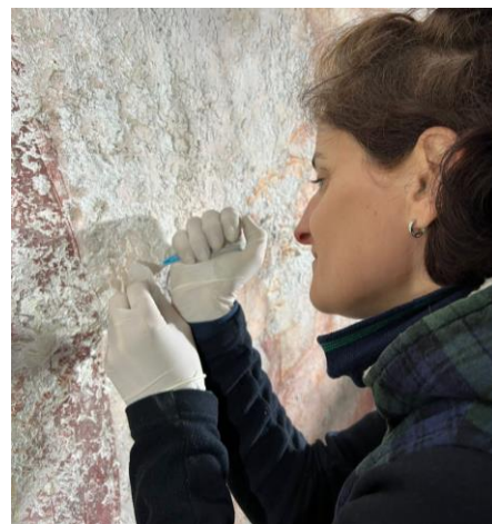
ზემოთ: 2024 წლის მარტის ფიზიკური სამუშაოების ერთ-ერთ მიზანს მეთოდოლოგიის შემუშავება წარმოადგენს. ფოტოებზე ჩარევის მეთოდოლოგიის განვითარების, კერძოდ კონსოლიდაციისა და მარილის მექანიკურად დათხელების სამუშაო პროცესებია წარმოდგენილი.
