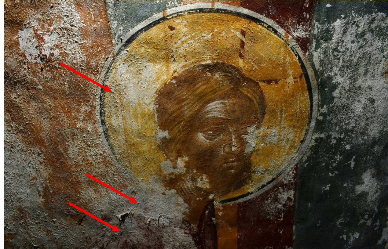
კონსოლიდირებული ადგილის აჟამინდელი მდგომარეობა, მარილებითა და ფერწერის ცვენის ლოკაციების მითითებით, ივლისი 2023 Condition of the treated areas today with salt efflorescence and further losses, July 2023
