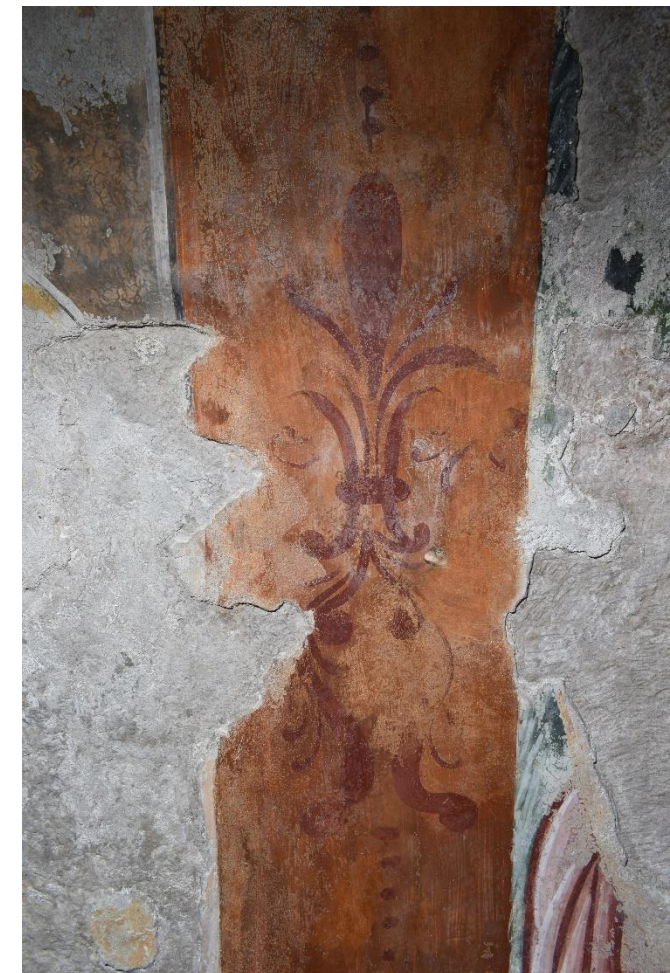
დღევანდელი მდგომარეობა, გამომარილება ივლისი 2023 Current state, Salt efflorescence July 2023
