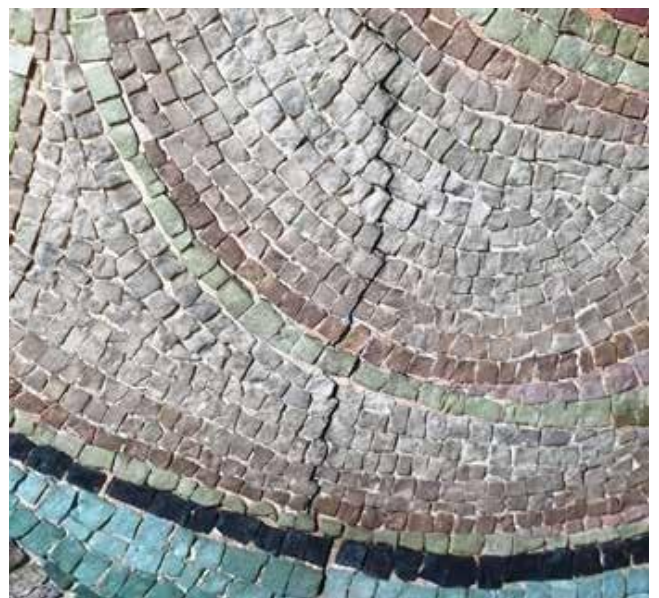
7-9. მოზაიკის ზედაპირი დღეს რამდენიმე ნაპრალით არის დადღასმული.
