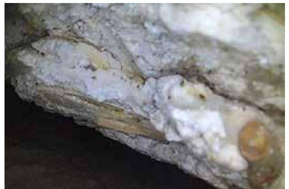
8-9. ჩალის ელემენტების დეტალები, რომელიც ჩამაგრებულია დულაბში
