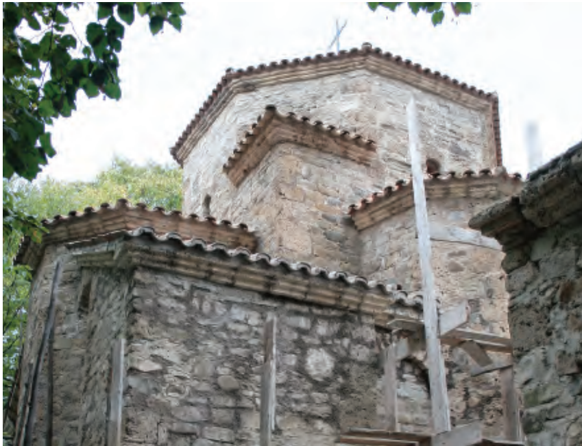
კომპლექსის ყველა ნაგებობაზე კრამიტის ახალი სახურავი დავიო | New Tile Roofs were Arranged on Each of the Complex Buildings
