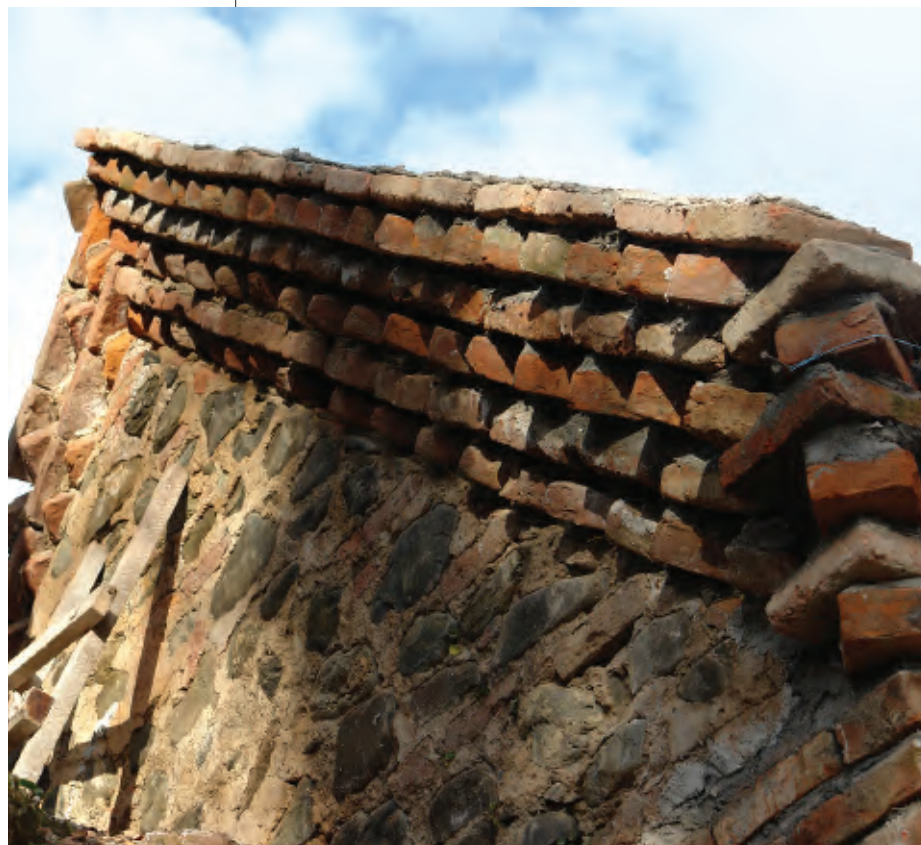
აგურის წყობით აღდგა დაზიანებული კარნიშები All Damaged Sections of the Cornice were remade with brickwork
