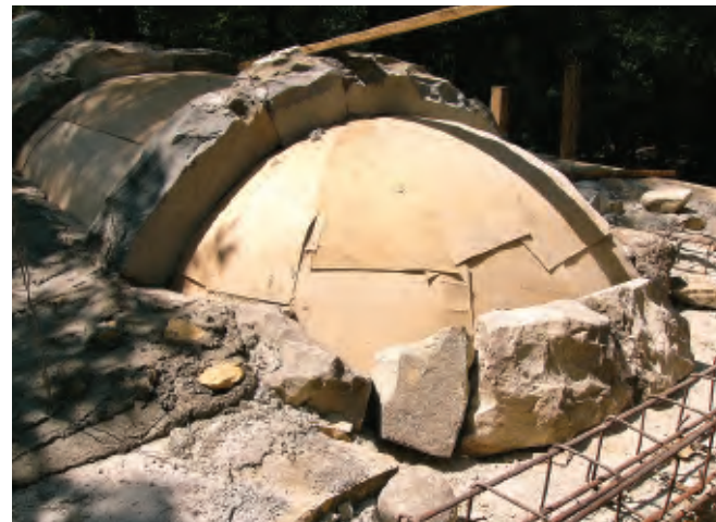
აღდგა ცილინდრული კამარა და აფსიდის მეოთხედსფერული კონქი The Cylinder-Shape Vault and Quarter-Sphere Configuration Conch of the Apse were Restored
