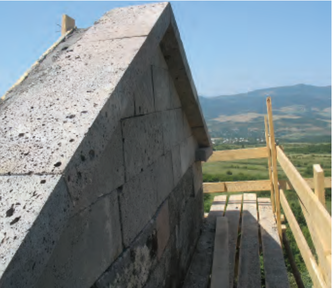
სუფთად გათლილი ბაზალტის ქვით აღდგა აღმოსავლეთისა და დასავლეთის ფრონტონები | Western and Eastern Pediments were Restored Using Neatly Hewn Basalt Rocks
