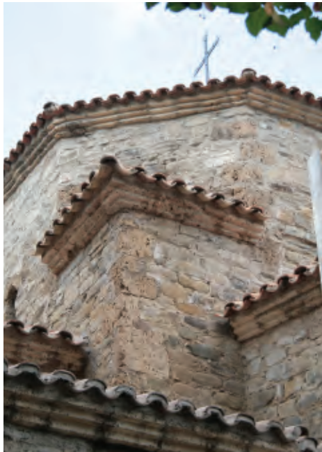
კომპლექსის ყველა ნაგებობაზე კრამიტის ახალი სახურავი დავიო | New Tile Roofs were Arranged on Each of the Complex Buildings
