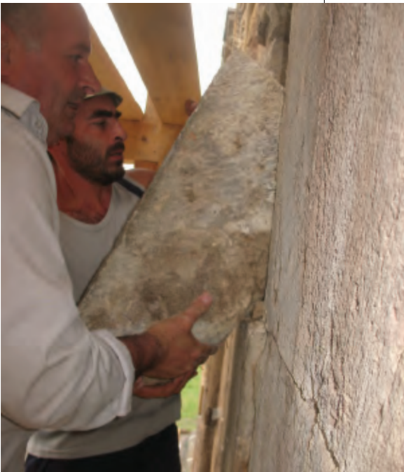
საფასადე ქვების ვადანყობა Re-Arrangement of the Facing Stones
