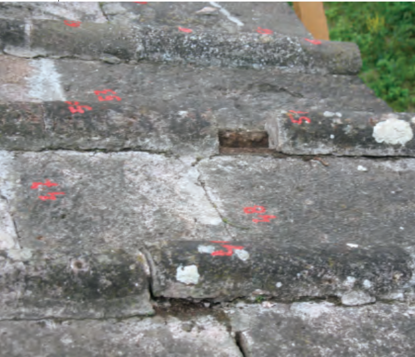
დანიშნა, გადენა და ხელახლა დაფიქსირებული ქვები | All Facing Stones were Numbered, Re-Arranged and Re-Fixed
