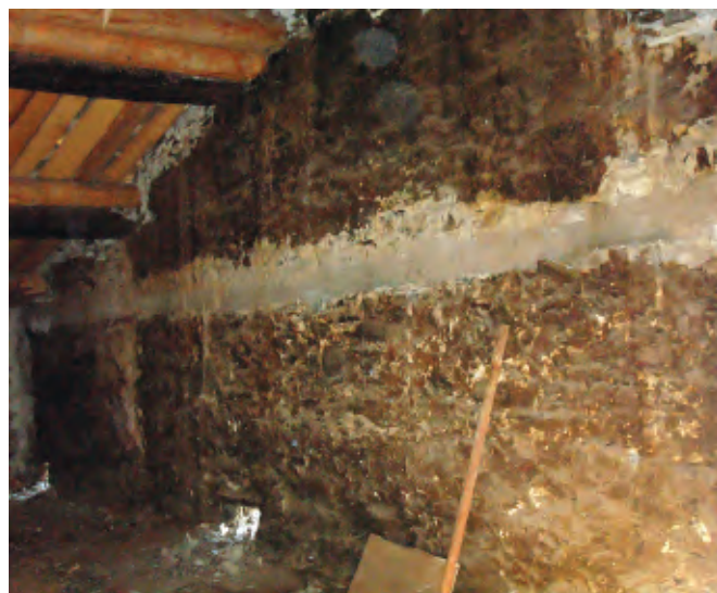
კედლის სიღრმეში მოეწყო რკინა-ბეტონის შემკვრელები Armored Concrete Stabilizers Arranged in the Load Bearing Wall Deep Layers
