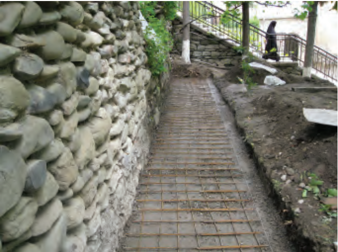
კედლის საძირკვლის მოწყობის პროცესი | Construction of the Wall Basement
