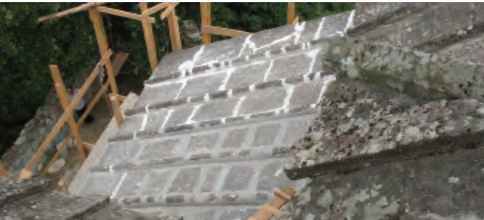
შოვები შეესო ჰიდროიზლაციის ხსნარით All Seams were Filled-up by Waterproof Solution
