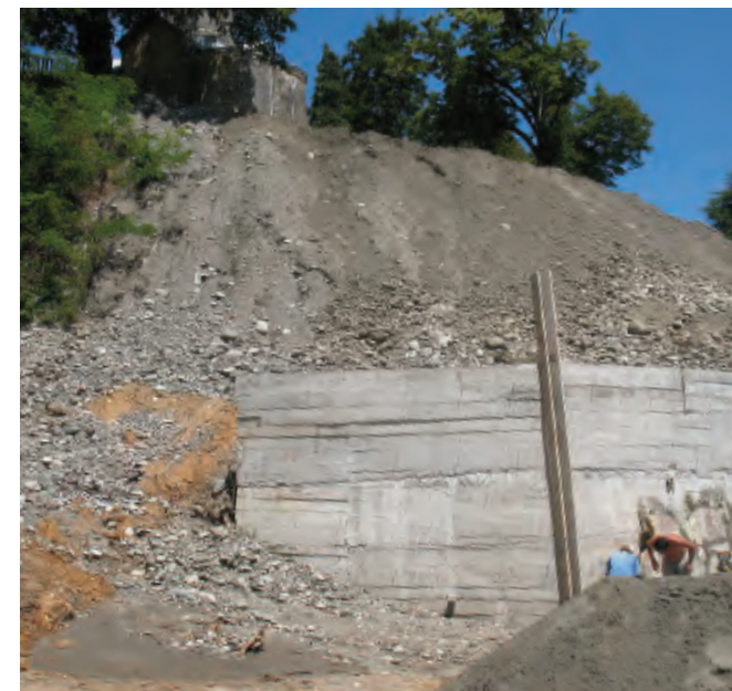
საყრდენი კედლის მოწყობის პროექტი | Arrangement of the Abutment in Progress
