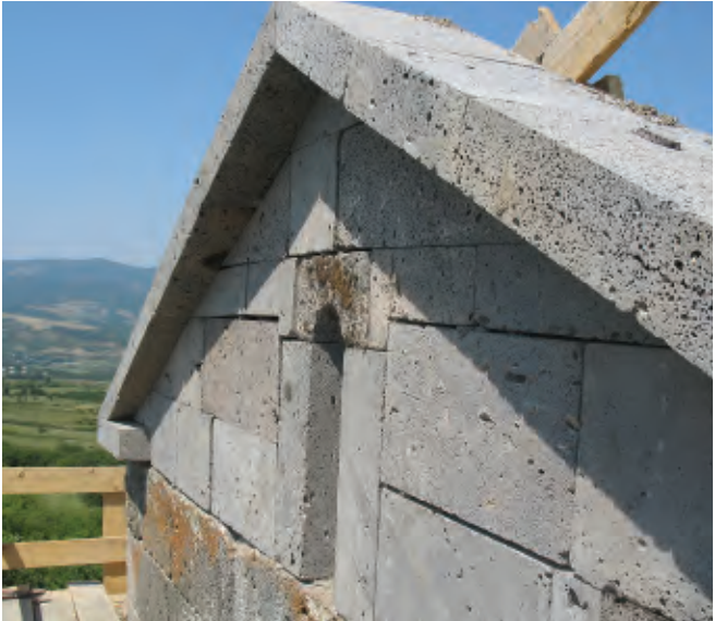
სუფთად გათლილი ბაზალტის ქვით აღდგა აღმოსავლეთისა და დასავლეთის ფრონტონები | Western and Eastern Pediments were Restored Using Neatly Hewn Basalt Rocks
