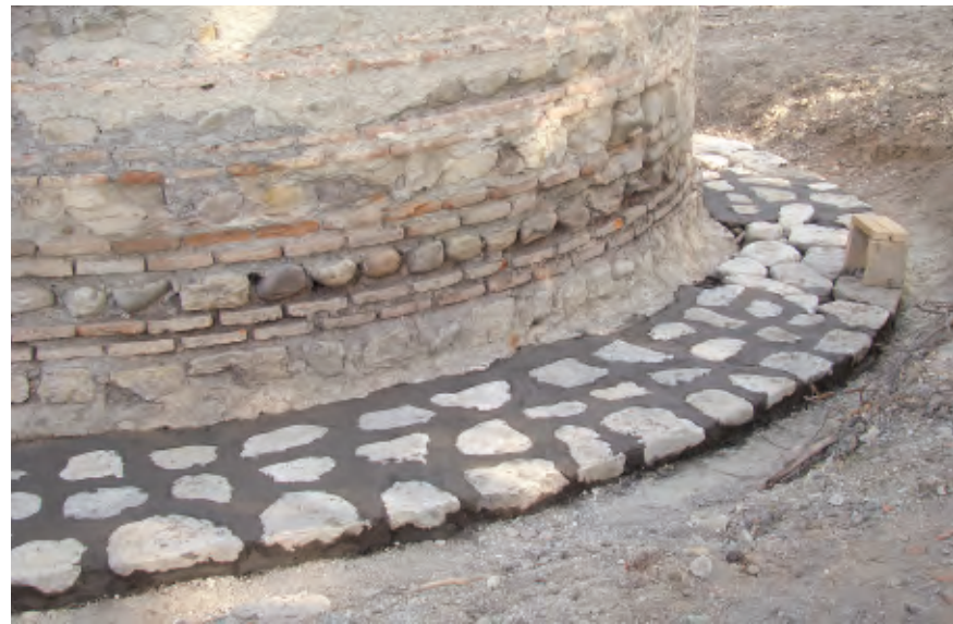
აღდგენილი სარინელი | Restored Storm-Water Divert Channel
