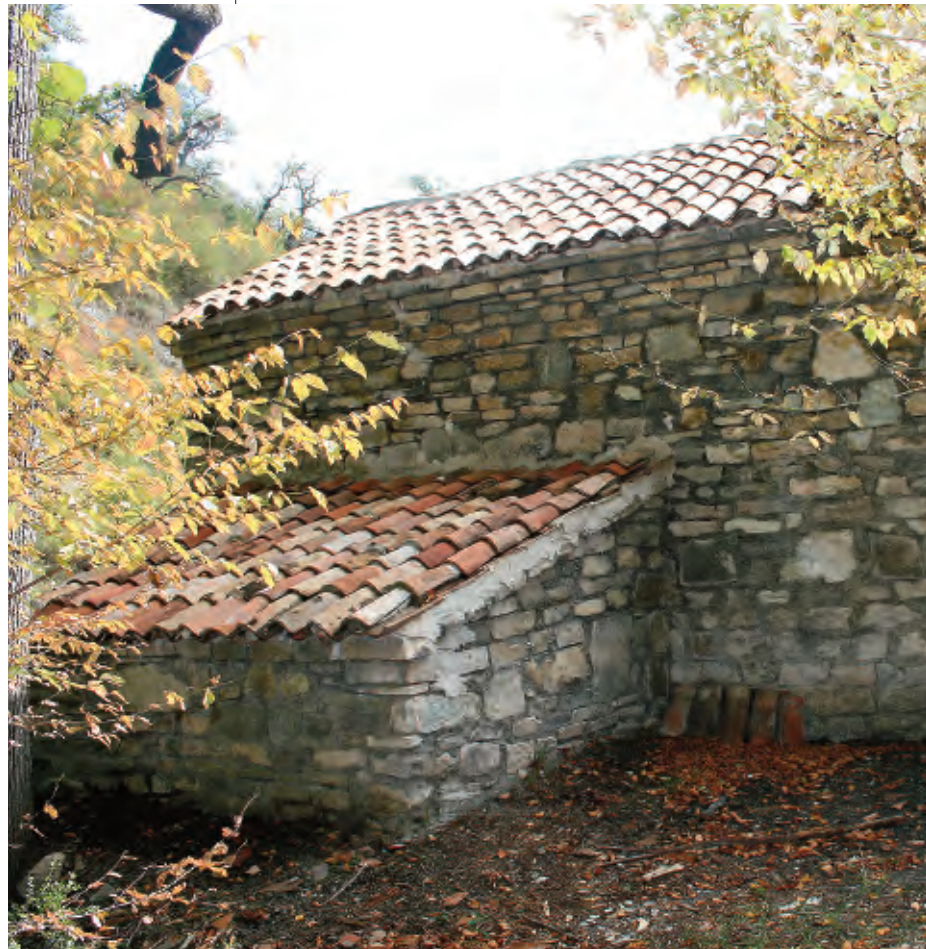
დაიგო ახალი კრამიტის სახურავი | New grooved tile roof was arranged
