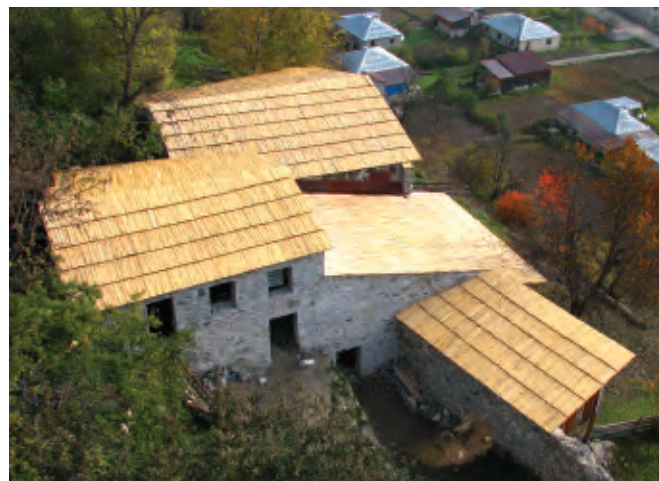
ყავარის ახალი სახურავი | New Shingle Roof
