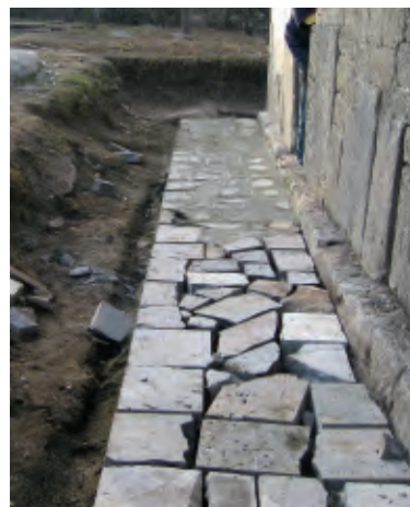
სარინელის დაგების პროცესი Laying of the New Water Divert Channel
