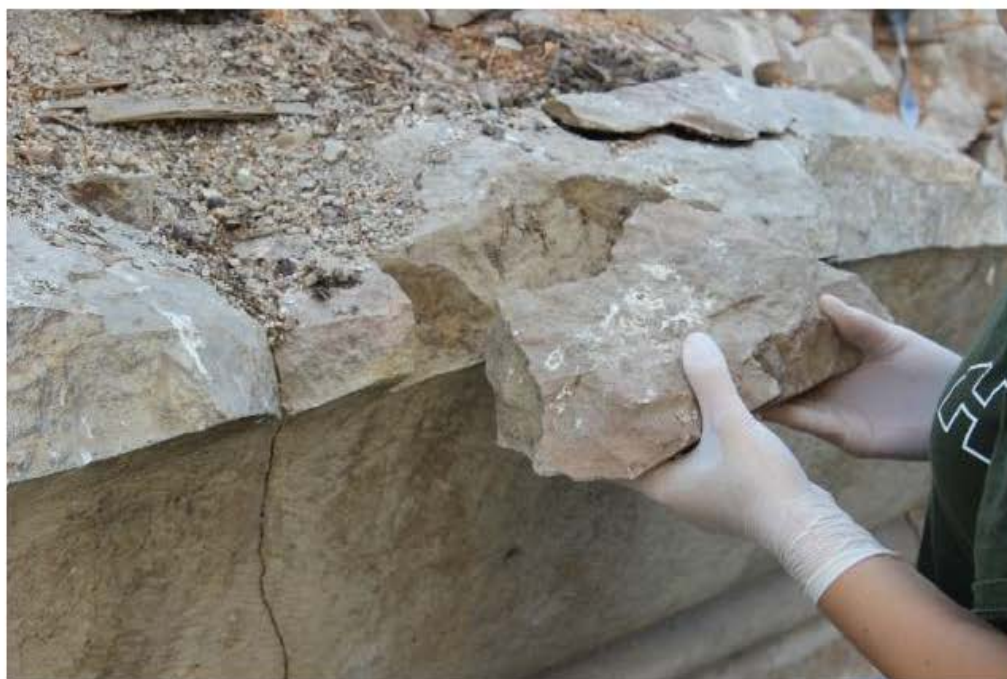
ფოტო: დასავლეთი ეკვდერი, ფრაგმენტირებული კარნიზის ქვის გამთლიანების პროცესი
