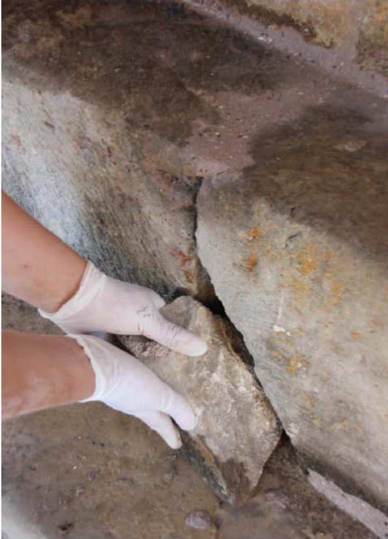
ჩრდილოეთ ფასადის ცოკოლი. ცოკოლი ფრაგმენტული ქვის განცალკევება და ელასტიური ეპოქსიდური რეზინით დამუშავების პროცესი
