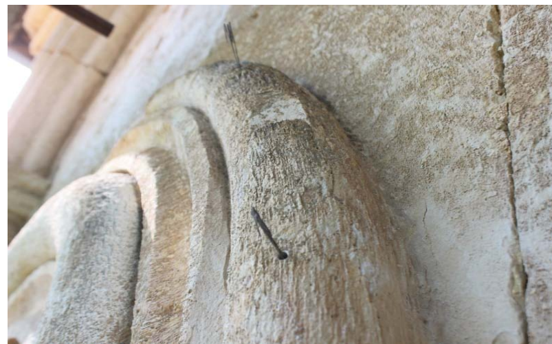
ჩრდილოეთ ფასადი . საანკრელე წერტილის ამოსუფთავება ჰაერის ჭავლით,მონტაჟი და შემდეგ მისი ეპოქსიდური რეზინით ფიქსაცია
