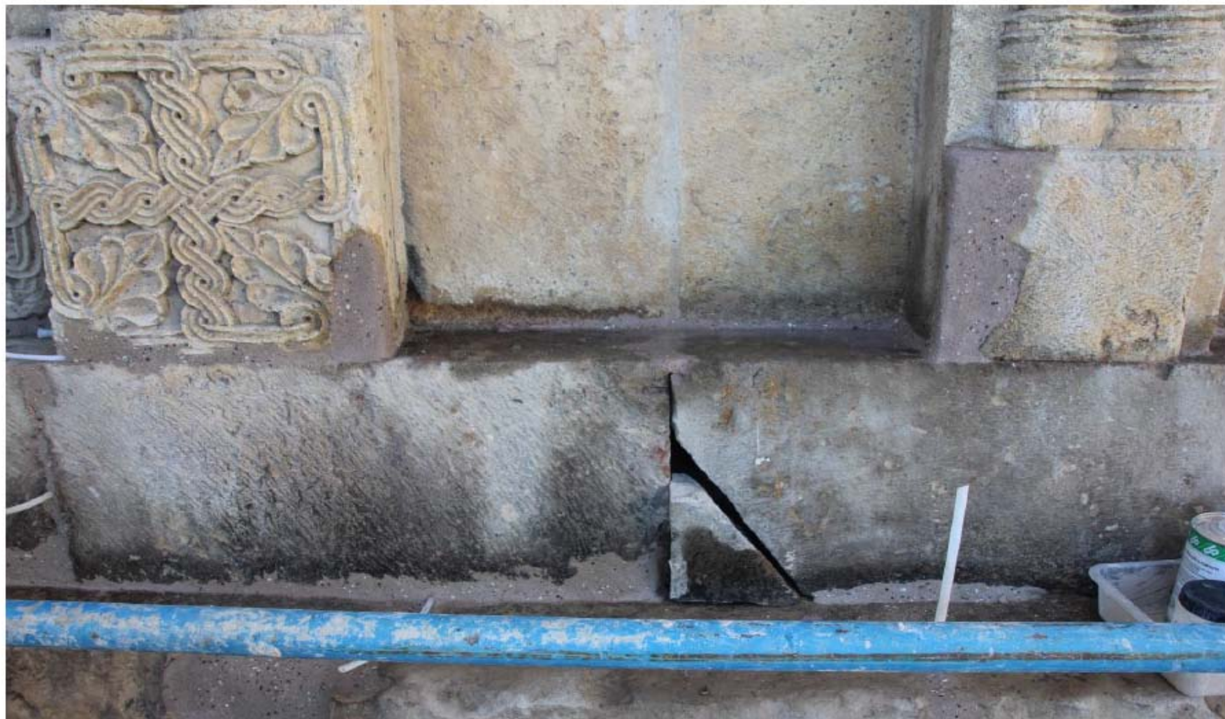
ჩრდილოეთ ფასადის ცოკოლი. ფრაგმენტირებული ქვის ზედაპირი
