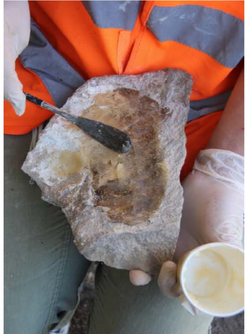
ჩრდილოეთ ფასადის ცოკოლი. ცოკოლი ფრაგმენტული ქვის განცალკევება და ელასტიური ეპოქსიდური რეზინით დამუშავების პროცესი
