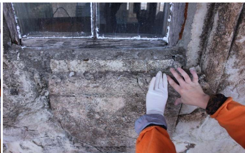
დასავლეთ ფასადი. ქვის ფრაგმენტების შეწყობვა პარალოიდ B72 ხსნარით
