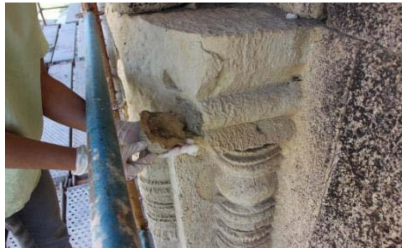
ზემოთ: ფოტო. დასავლეთ ეკვდერი. ქვის ფრაგმენტირებული დეტალის გაერთიანების პროცესი.
