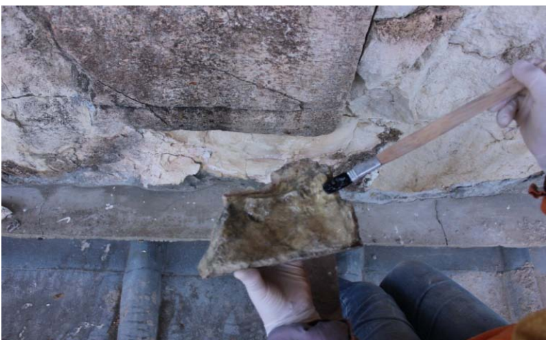
დასავლეთ ფასადი. ქვის ფრაგმენტების შეწყობვა პარალოიდ B72 ხსნარით
