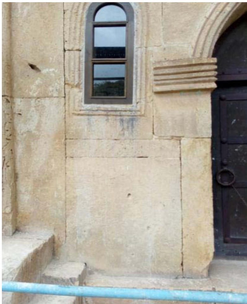
მარცხნივ/ზემოთ: ფოტო.სამხრეთ ფასადი. კირხსნარით რეკონსტრუქციამდე. მარჯვნივ/ზემოთ: ფოტო.სამხრეთ ფასადი. კირხსნარით რეკონსტრუქციის შემდეგ.
