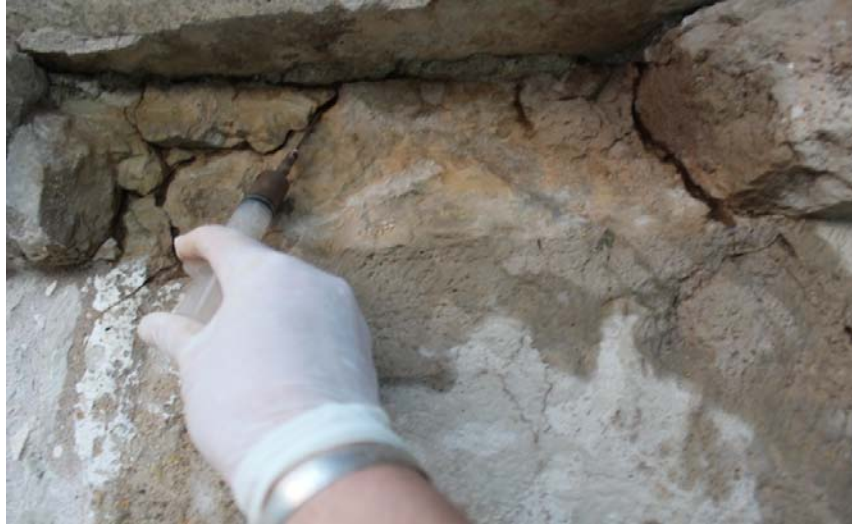
გუმბათი. ზზარების კონსოლიდაცია.ინექტირება.რეკონსტრუქცია კირხსნარით
