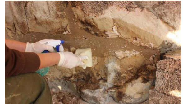
დასავლეთ ფასადი. კირის ხსნარით შევსების თანმიმდევრული პროცესი. ცემენტის ძველი შევსების მექანიკური მოცილება, ბზარის ჰაერის ჭავლით წმენდა, კირხსნარით შევსება.
