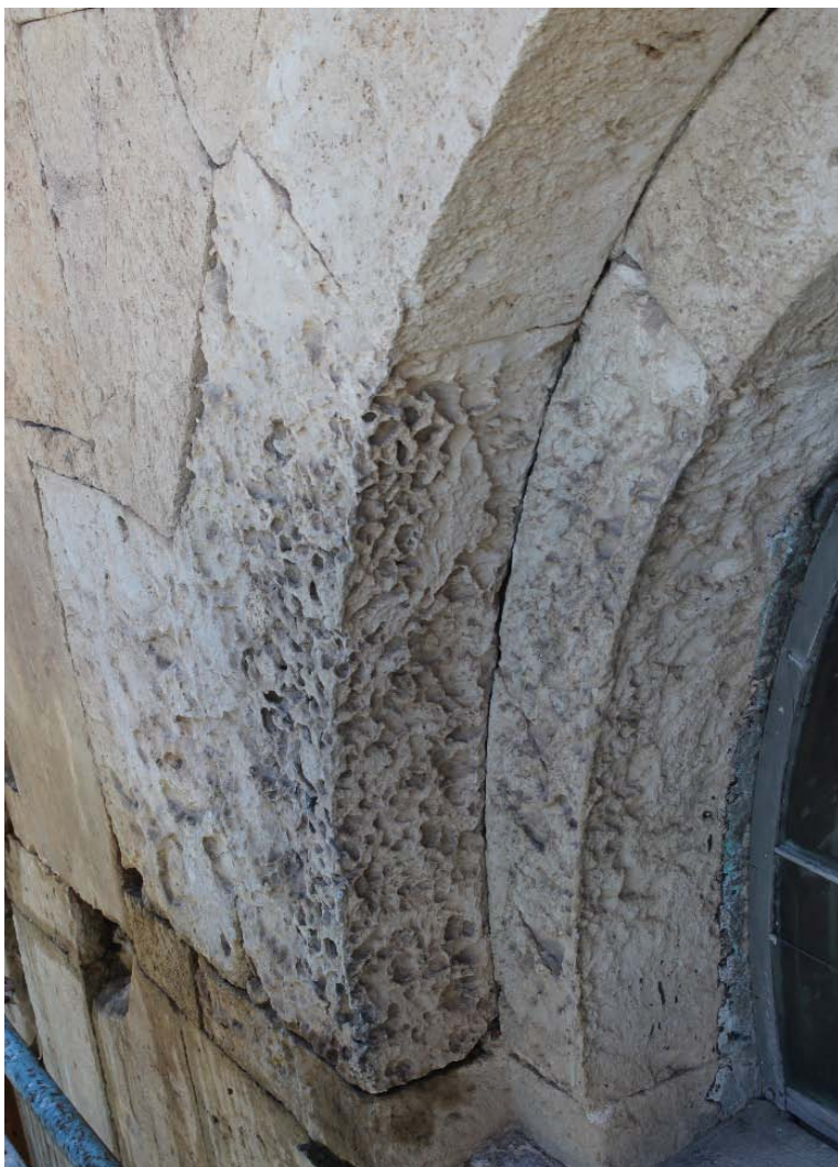
ჩრდილოეთ ეკვდერი. მარცხნივ/ფოტო. ჩრდილოეთ ეკვდერის საპირე წყობის დაზიანებული ქვა. სარესტავრაციო პროცესამდე. მარჯვნივ/ ფოტო. ჩრდილოეთ ეკვდერის საპირე წყობის დაზიანებული ქვა. სარესტავრაციო პროცესების შემდგომ
