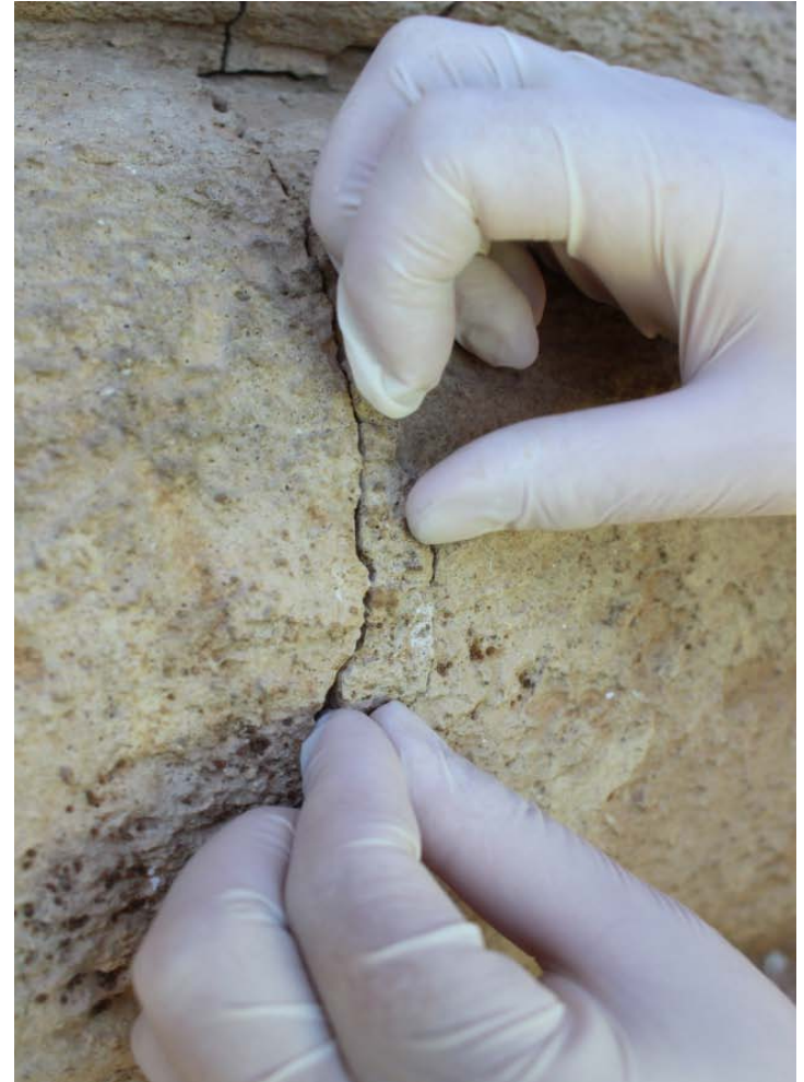
გუმბათი. ქვის ფრაგმენტირებული ნაწილების გაერთიანება ეპოქსიდის წებოთი
