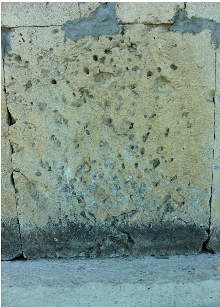
ჩრდილოეთ ეკვდერი. მარცხნივ , ფოტო. ჩრდილოეთ ეკვდერის საპირე წყობის დაზიანებული ქვა. სარესტავრაციო პროცესამდე. მარჯვნივ , ფოტო. ჩრდილოეთ ეკვდერის საპირე წყობის დაზიანებული ქვა. სარესტავრაციო პოცესების შემდგომ
