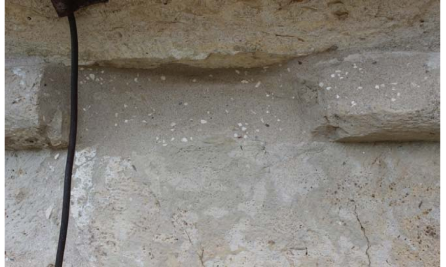
გუმბათი. ზზარების კონსოლიდაცია.ინექტირება.რეკონსტრუქცია კირხსნარით
