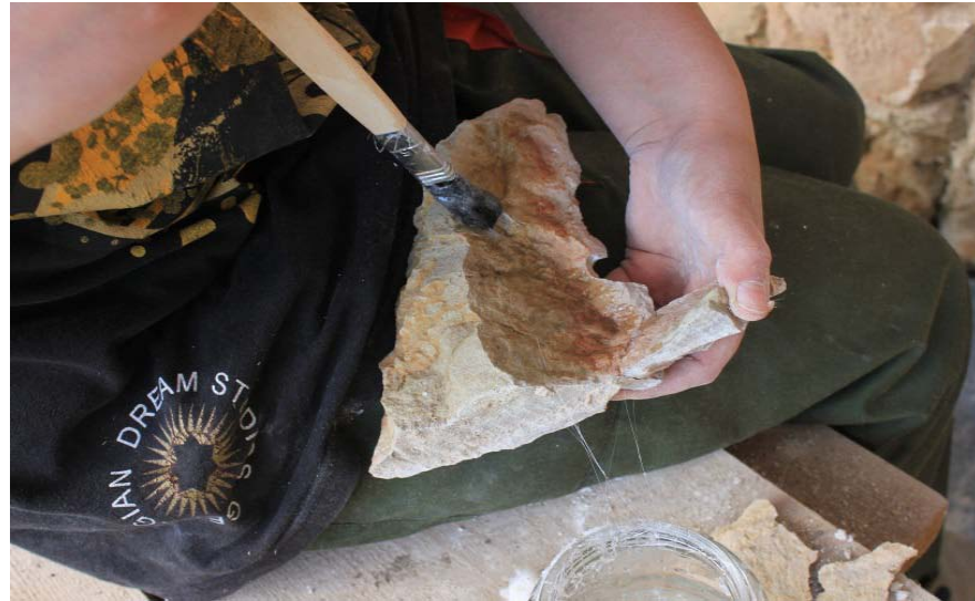
დასავლეთ ფასადი. ქვის ფრაგმენტის შეწეპება ეპოქსიდური რეზინით
