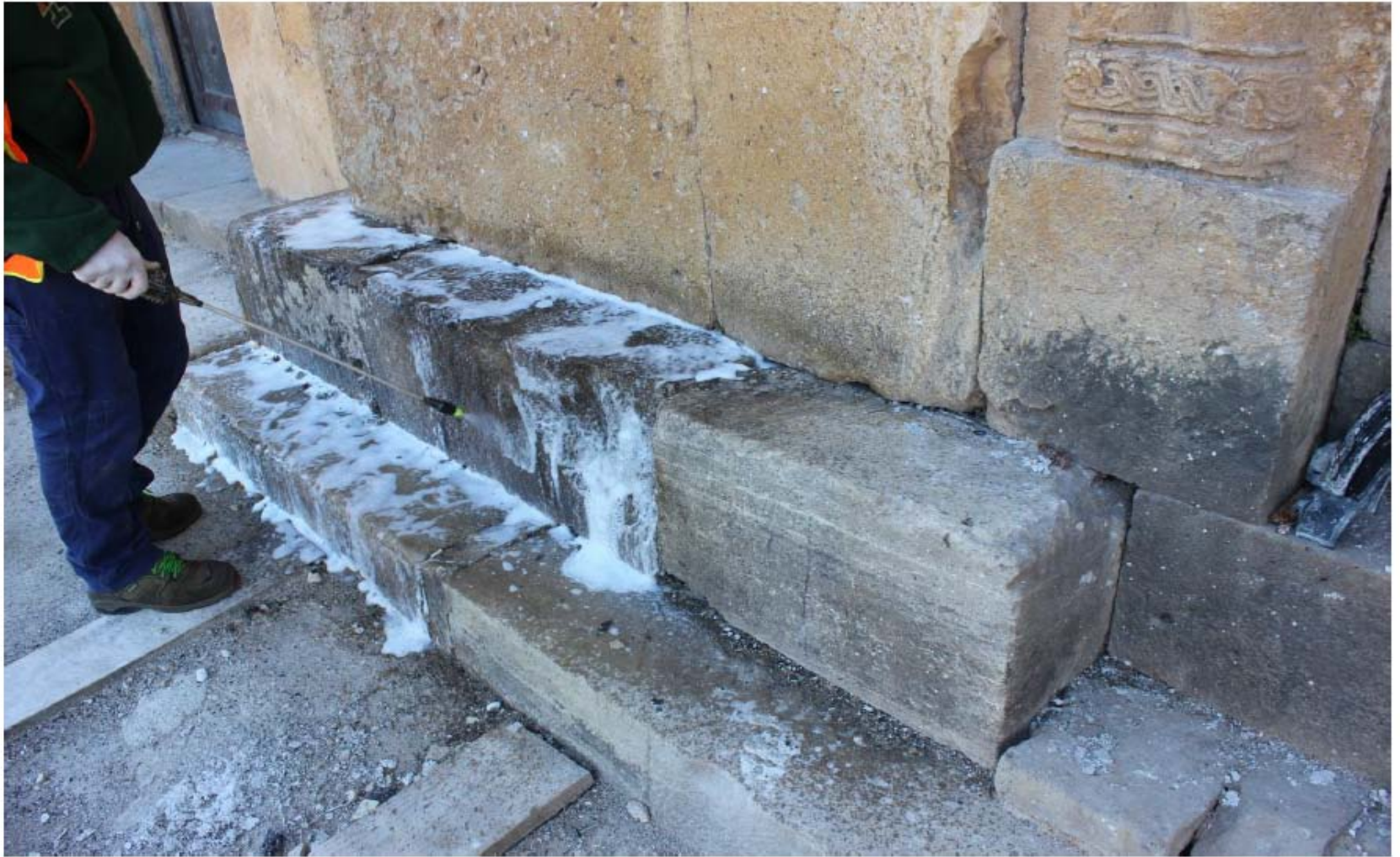
ჩრდილოეთ ფსაადის ცოკოლი. ბიოლოგიური დაზიანების ბიოციტ მკურნალობა
