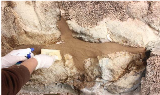
დასავლეთ ფასადი. კირის ხსნარით შევსების თანმიმდევრული პროცესი. ცემენტის ძველი შევსების მექანიკური მოცილება, ბზარის ჰაერის ჭავლით წმენდა, კირხსნარით შევსება.
