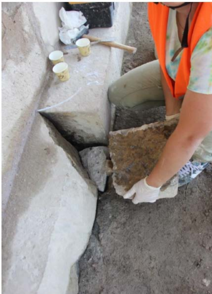
ჩრდილოეთ ფასადის ცოკოლი ფოტო: დაზიანებული ქვის აუთენტურ ადგილას დაბრუნების პროცესი
