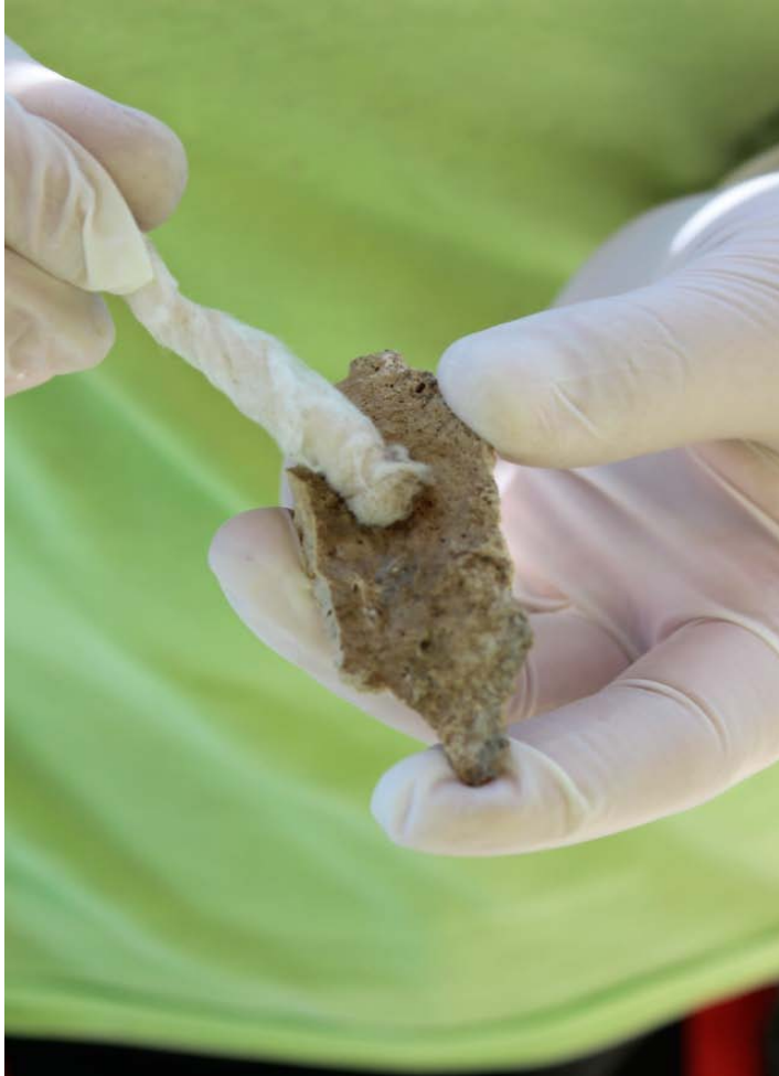
გუმბათი. ქვის ფრაგმენტირებული ნაწილების გაერთიანება ეპოქსიდის წებოთი
