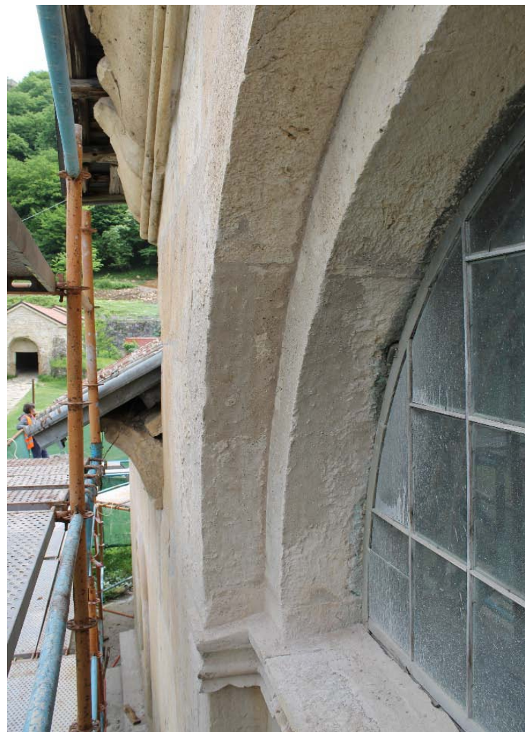
ჩრდილოეთ ეკვდერი. მარცხნივ/ფოტო. ჩრდილოეთ ეკვდერის საპირე წყობის დაზიანებული ქვა. სარესტავრაციო პროცესამდე. მარჯვნივ/ ფოტო. ჩრდილოეთ ეკვდერის საპირე წყობის დაზიანებული ქვა. სარესტავრაციო პროცესების შემდგომ
