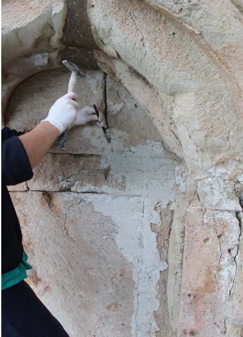
დასავლეთ ფასადი. ცემენტის ხსნარის შევსებების მექანიკური მოხსნა
