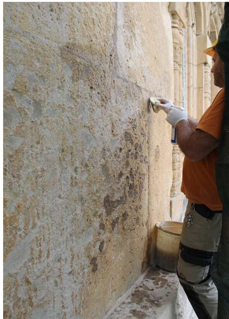
ჩრდილოეთ ეკვდერი. მარცხნივ , ფოტო. ჩრდილოეთ ეკვდერის საპირე წყობის დაზიანებული ქვა. სარესტავრაციო პროცესამდე. მარჯვნივ , ფოტო. ჩრდილოეთ ეკვდერის საპირე წყობის დაზიანებული ქვა. სარესტავრაციო პოცესების შემდგომ
