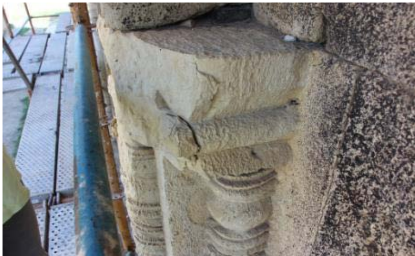
ზემოთ: ფოტო. დასავლეთ ეკვდერი. ქვის ფრაგმენტირებული დეტალის გაერთიანების პროცესი.
