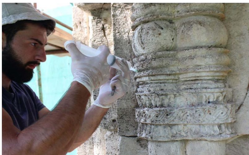
ჩრდილოეთ ფასადი . საანკრელე წერტილის ამოსუფთავება ჰაერის ჭავლით,მონტაჟი და შემდეგ მისი ეპოქსიდური რეზინით ფიქსაცია
