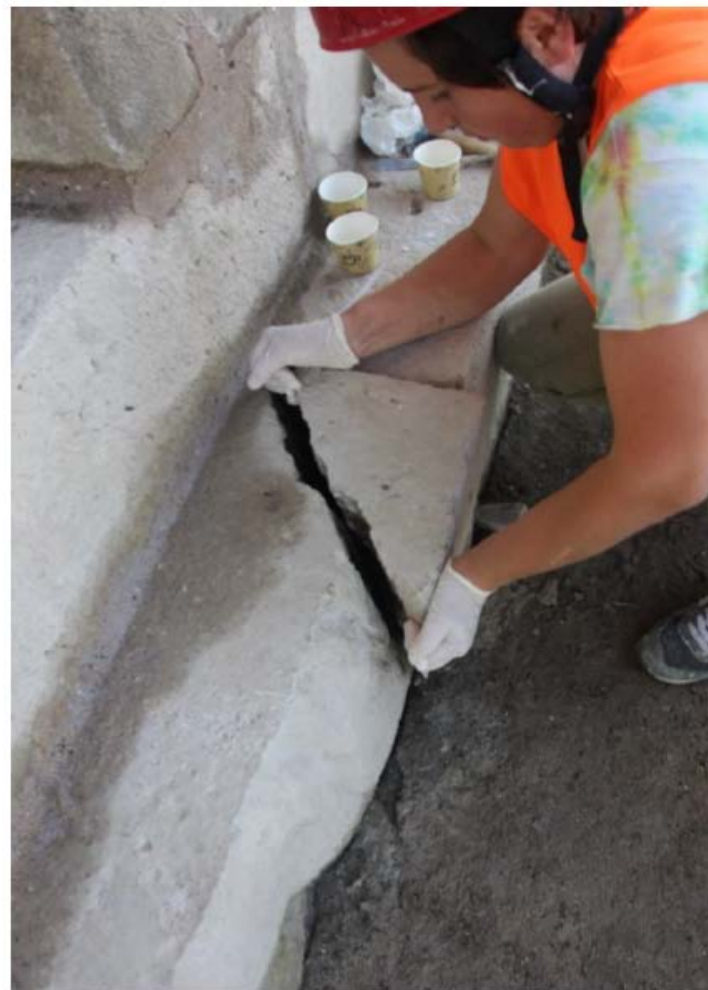
ჩრდილოეთ ფასადის ცოკოლი ფოტო: დაზიანებული ქვის აუთენტურ ადგილას დაბრუნების პროცესი
