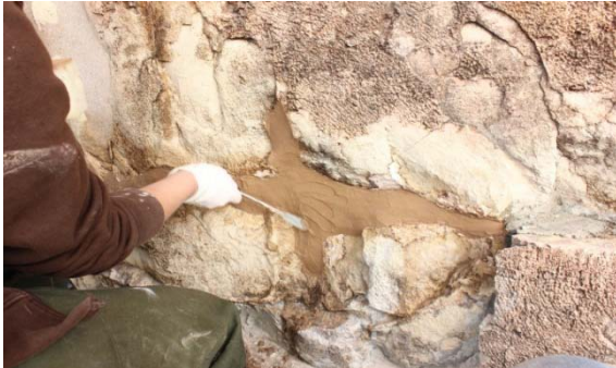
დასავლეთ ფასადი. კირის ხსნარით შევსების თანმიმდევრული პროცესი. ცემენტის ძველი შევსების მექანიკური მოცილება, ბზარის ჰაერის ჭავლით წმენდა, კირხსნარით შევსება.
