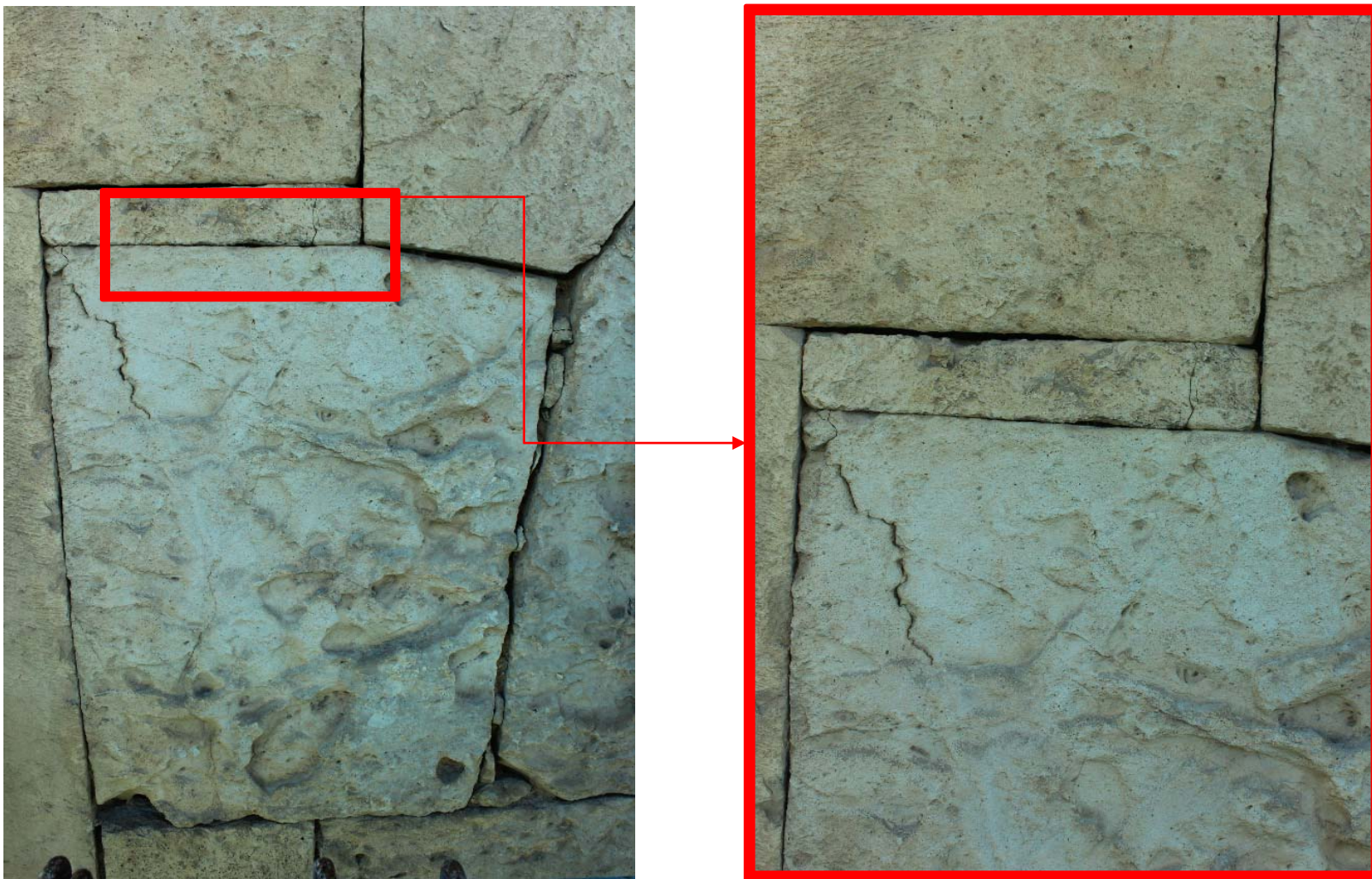
ჩრდილოეთ ეკვდერი. მარცხნივ ფოტო. ჩრდილოეთ ეკვდერის საპირე წყობის დაზიანებული ქვა. კონტექსტი. მარჯვნივ ფოტო. ჩრდილოეთ ეკვდერის საპირე წყობის დაზიანებული ქვა. დეტალი.
