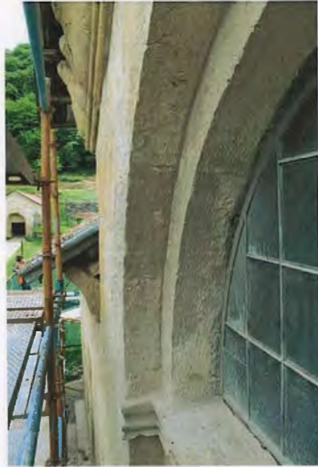
მარცხნივ/ზემოთ ფოტო. ჩრდილოეთ ეკვდერის საპირე წყობის დაზიანებული ქვა. სარესტავრაციო პროცესამდე. მარჯვნივ/ზემოთ ფოტო. ჩრდილოეთ ეკვდერის საპირე წყობის დაზიანებული ქვა. სარესტავრაციო პოცესების შემდგომ
