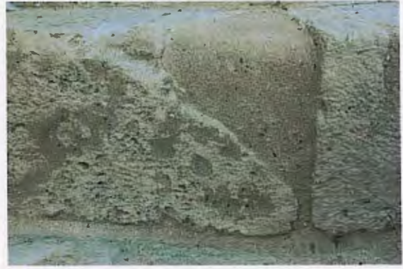
ზემოთ მარცხნივ: ფოტო. ცოკოლი. დაზიანებული ქვის ზედაპირი. ფოტო რეკონსტრუქციამდე ზემოთ მარჯვნივ: ფოტო. ცოკოლი. ფოტო რეკონსტრუქციის შემდეგ.
