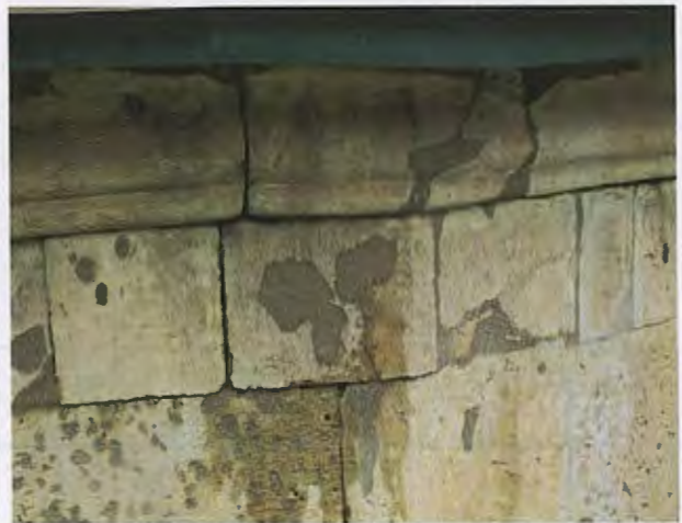
მარგხნიე/ზემოთა ფოტო. ჩრდილოეთ ეკვდერის საპირე წყობის დაზიანებული ქვა. კონტექსტი. მარჯვნიე/ზემოთა ფოტო. ჩრდილოეთ ეკვდერის საპირე წყობის დაზიანებული ქვა. დეტალი.
