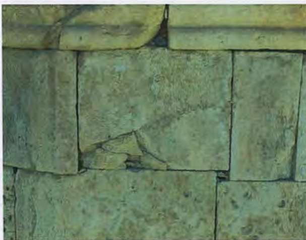
მარგხნიე/ზემოთა ფოტო. ჩრდილოეთ ეკვდერის საპირე წყობის დაზიანებული ქვა. კონტექსტი. მარჯვნიე/ზემოთა ფოტო. ჩრდილოეთ ეკვდერის საპირე წყობის დაზიანებული ქვა. დეტალი.
