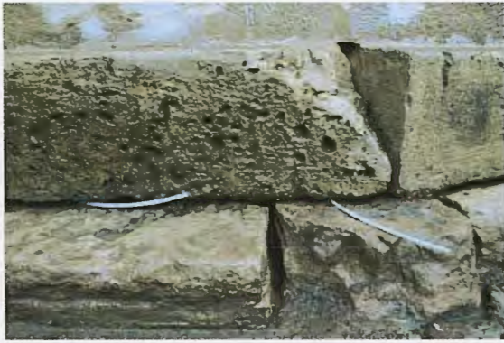
ზემოთ მარცხნივ: ფოტო. ცოკოლი. დაზიანებული ქვის ზედაპირი. ფოტო რეკონსტრუქციამდე ზემოთ მარჯვნივ: ფოტო. ცოკოლი. ფოტო რეკონსტრუქციის შემდეგ.
