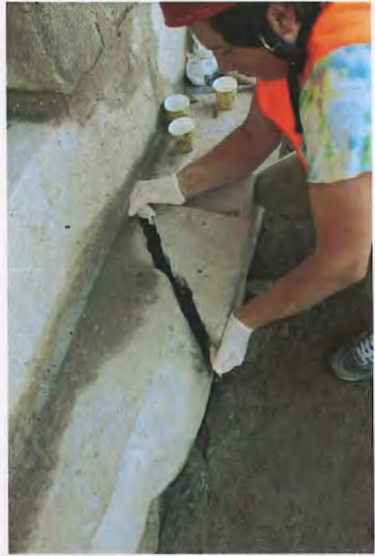
ზემოთ: ფოტო. დაზიანებული ქვის ავთენტიკურ ადგილას დაბრუნების პროცესი.
