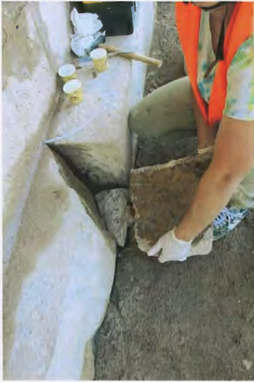
ზემოთ: ფოტო. დაზიანებული ქვის ავთენტიკურ ადგილას დაბრუნების პროცესი.
