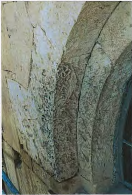
მარცხნივ/ზემოთ ფოტო. ჩრდილოეთ ეკვდერის საპირე წყობის დაზიანებული ქვა. სარესტავრაციო პროცესამდე. მარჯვნივ/ზემოთ ფოტო. ჩრდილოეთ ეკვდერის საპირე წყობის დაზიანებული ქვა. სარესტავრაციო პოცესების შემდგომ
