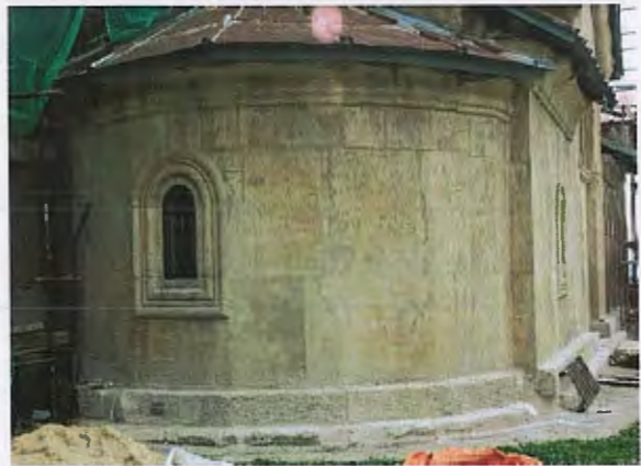
მარჯვნივ/ზემოთ ფოტო. დაზიანებული ცოკოლის ქვა. სარესტავრაციო პროცესამდე. მარჯვნივ/ზემოთ ფოტო. კონსერვირებული ცოკოლის ქვა. სარესტავრაციო პოცესების შემდგომ
