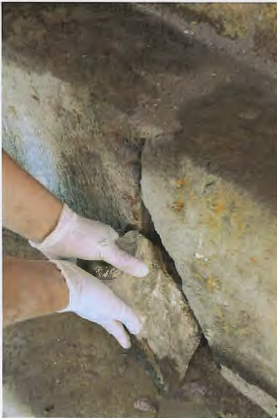
ზემოთ : ფოტო. ცოკოლი, ფრაგმენტირებული ქვის განცალკევება და ელასტიური ეპოქსიდური რეზინით დამუშავების პროცესი.
