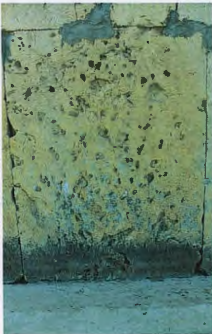
მარცხნივ/ზემოთ ფოტო. ჩრდილოეთ ეკვდერის საპირე წყობის დაზიანებული ქვა. სარესტავრაციო პროცესამდე. მარჯვნივ/ზემოთ ფოტო. ჩრდილოეთ ეკვდერის საპირე წყობის დაზიანებული ქვა. სარესტავრაციო პოცესების შემდგომ
