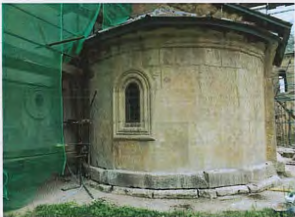
მარჯვნივ/ზემოთ ფოტო. დაზიანებული ცოკოლის ქვა. სარესტავრაციო პროცესამდე. მარჯვნივ/ზემოთ ფოტო. კონსერვირებული ცოკოლის ქვა. სარესტავრაციო პოცესების შემდგომ
