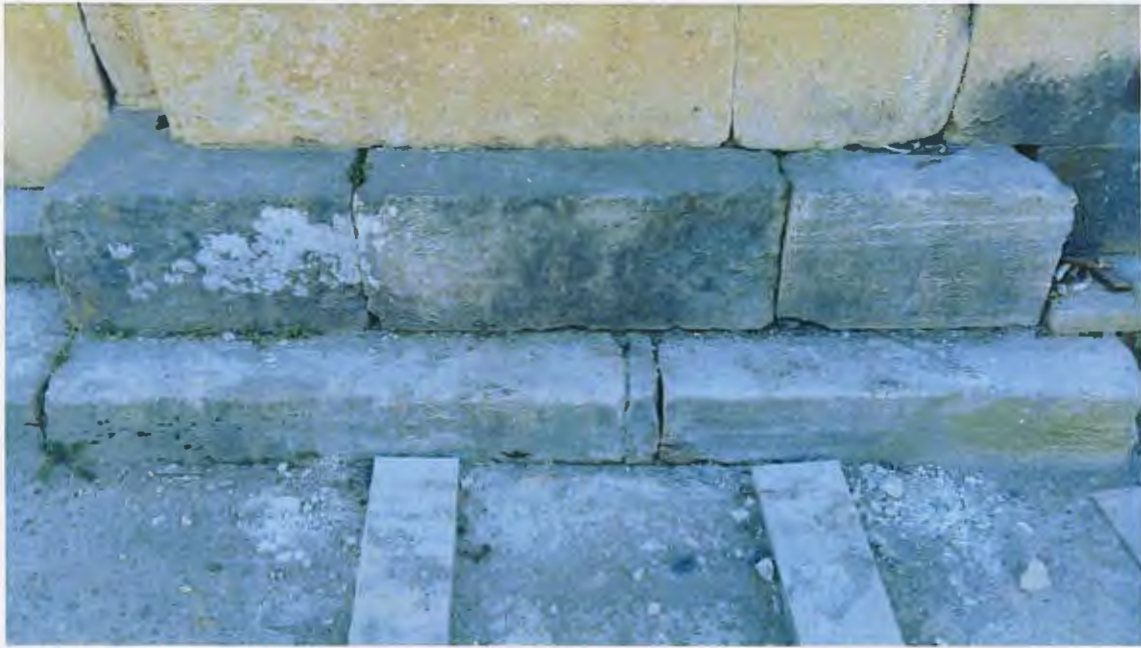
ზემოთ: ფოტო „ჩრდილოეთ პოსტამენტის ქვის ზედაპირზე არსებული ბიოლოგიური დაზიანებები.“
