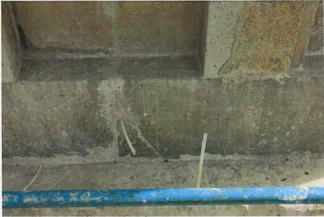
ზემოთ ფოტო. ცოკოლი, ფრაგმენტირებული ქვის უბანი. საბოლოო შედეგი.* *შენიშვნა- კონკრეტულ ადგილას დატოვებულია პლასტმასის საინექციო ტუბი.
