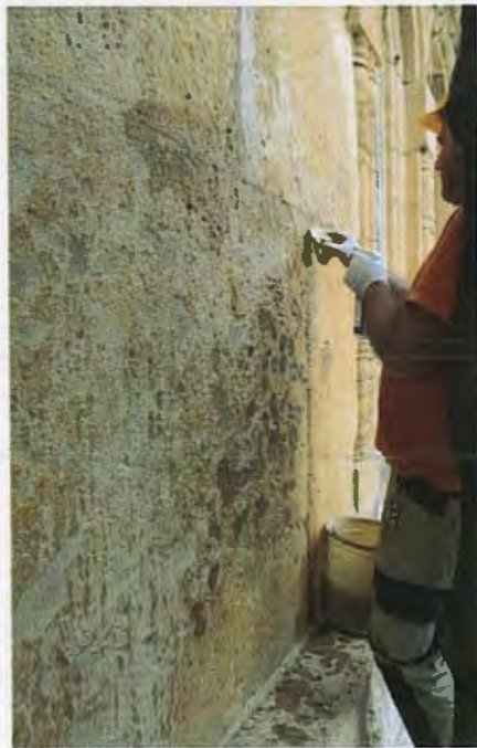
მარცხნივ/ზემოთ ფოტო. ჩრდილოეთ ეკვდერის საპირე წყობის დაზიანებული ქვა. სარესტავრაციო პროცესამდე. მარჯვნივ/ზემოთ ფოტო. ჩრდილოეთ ეკვდერის საპირე წყობის დაზიანებული ქვა. სარესტავრაციო პოცესების შემდგომ
