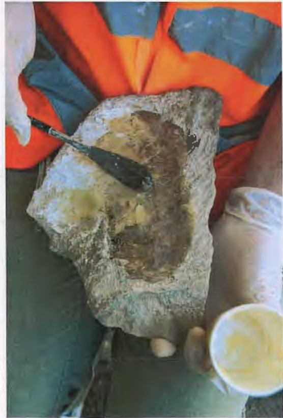
ზემოთ : ფოტო. ცოკოლი, ფრაგმენტირებული ქვის განცალკევება და ელასტიური ეპოქსიდური რეზინით დამუშავების პროცესი.
