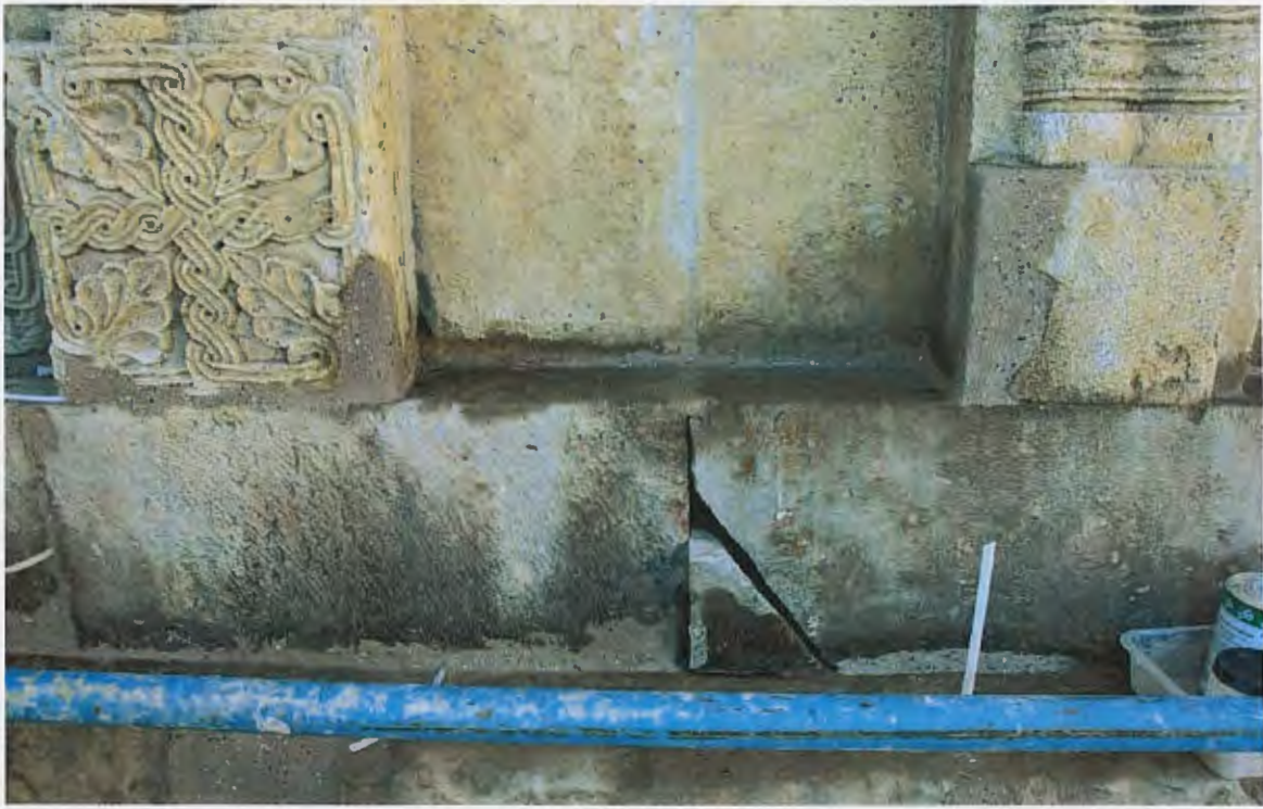
ზემოთ : ფოტო. ცოკოლი, ფრაგმენტირებული ქვის ზედაპირი.
