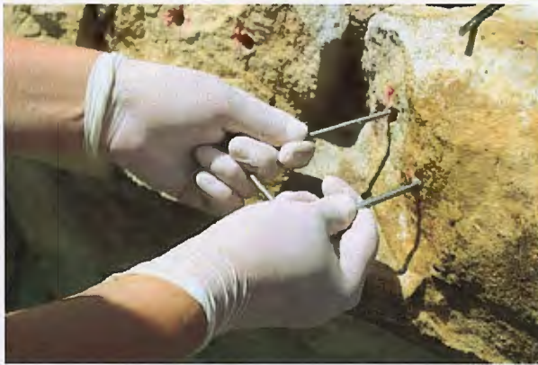
ზემოთაფოტო კარნიზი. უკანგავი ლითონის ანკერებით, არმირებისთვის განკუთვნილი კარნიზის მოწყობის პროცესი.
