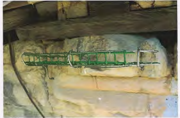
ზემოთ, მარჯვნივ: ფოტო. ჩრდილოეთ ფასადი. დაზიანებული კარნიზის ქვა ზემოთ, მარჯვნივ: ფოტო. ჩრდილოეთ ფასადი. კარნიზი. არმირებისთვის განკუთვნილი კარკასი.
