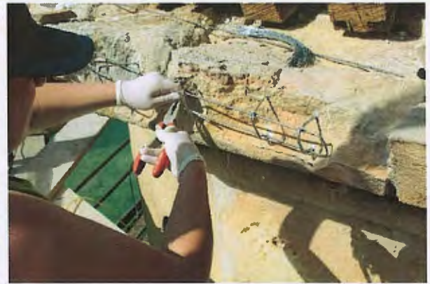
ზემოთაფოტო კარნიზი. უკანგავი ლითონის ანკერებით, არმირებისთვის განკუთვნილი კარნიზის მოწყობის პროცესი.
