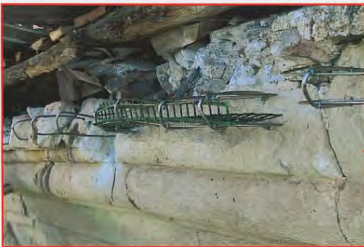
მარჯვნივ/ზემოთ : ფოტო 6მმ სისქის უჟანგავი ლითონითა და მინაბოჭკოვანი საარმირებო მადით არმირებული კარნიზის ქვა-დეტალი მარჯვნივ/ზემოთ ფოტო. ჩრდილოეთი ფასადი.კარნიზი.კონტექსტი.
