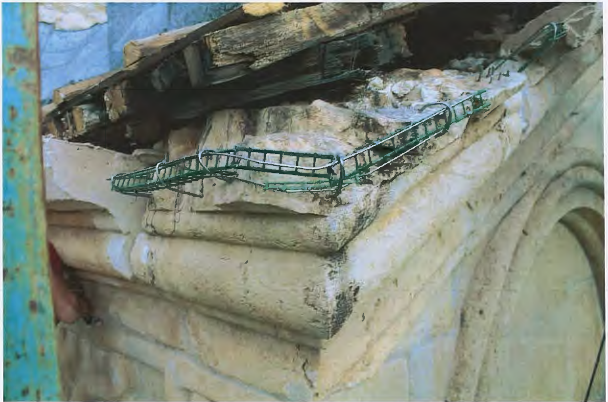
ზემოთ: ფოტო. დაზიანებული აკრნიზის ქვა. უქანგავი ლითონის არმირებისთვის განკუთვნილი კარკასი.
