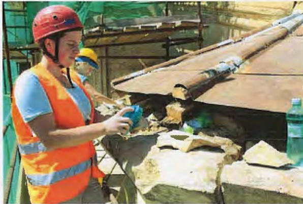
ზემოთ ფოტო. კარნიზი ქვის ფრაგმენტირებული დეტალების ეპოქსიდური რეზინით გაერთიანების პროცესი.
