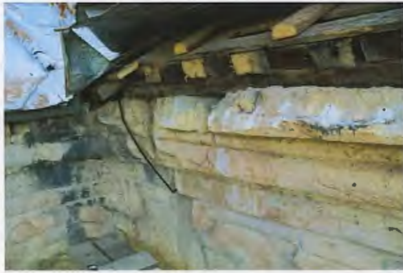
ზემოთ, მარჯვნივ: ფოტო. ჩრდილოეთ ფასადი. დაზიანებული კარნიზის ქვა ზემოთ, მარჯვნივ: ფოტო. ჩრდილოეთ ფასადი. კარნიზი. არმირებისთვის განკუთვნილი კარკასი.
