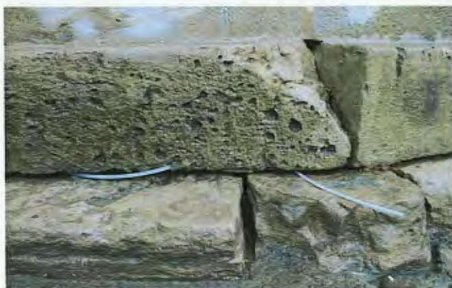
ზემოთ მარცხნივ: ფოტო. ცოკოლი. დაზიანებული ქვის ზედაპირი. ფოტო რეკონსტრუქციამდე ზემოთ მარჯვნივ: ფოტო. ცოკოლი. ფოტო რეკონსტრუქციის შემდეგ.
