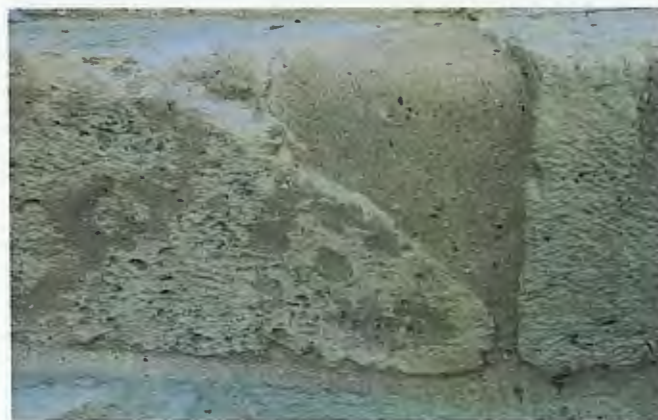
ზემოთ მარცხნივ: ფოტო. ცოკოლი. დაზიანებული ქვის ზედაპირი. ფოტო რეკონსტრუქციამდე ზემოთ მარჯვნივ: ფოტო. ცოკოლი. ფოტო რეკონსტრუქციის შემდეგ.
