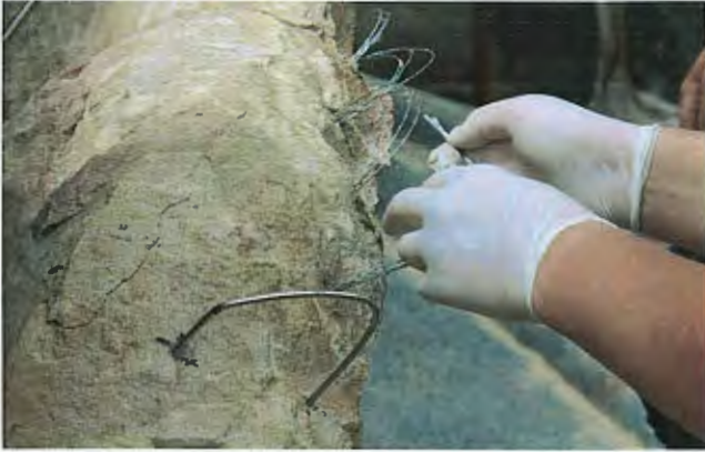
ზემოთფოტო კარნიზი.უჟანგავი ლითონის ანკერებით, არმირებისთვის განკუთვნილი კარნიზის მონტაჟის პროცესი.
