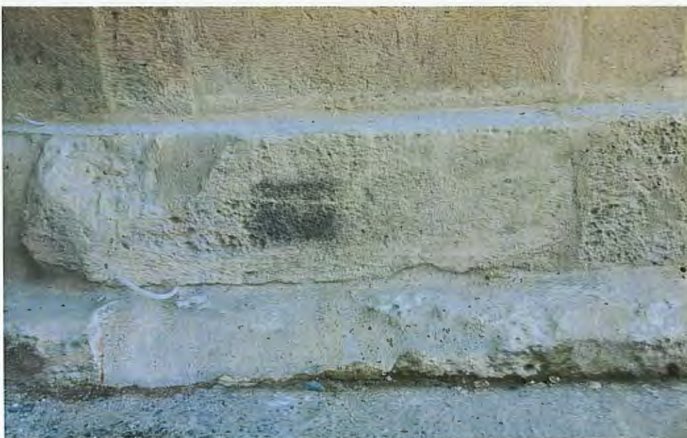
ზემოთ: ფოტო. ბიოციდით დამუშავებული და რეკონსტრუირებული ცოკოლის ქვა. შენიშვნა* ფოტოზე შავ ლაქად ჩანს ზონდაჟი. დატოვებულია სპეციალურად, გაწმენდამდე და გაწმენდის შემდეგ მდგომარეობის შედრეებისთვის
