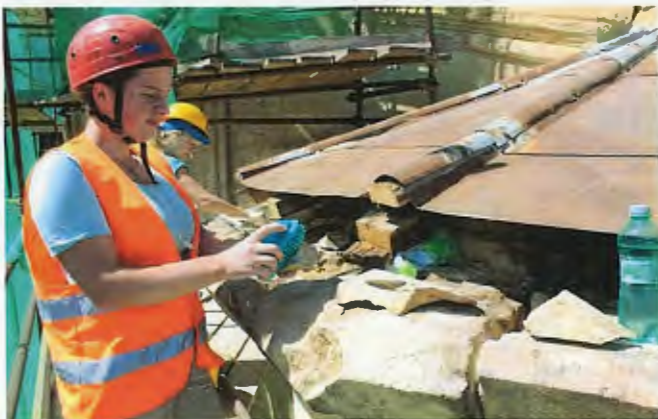
ზემოთ/ფოტო. კარნიზი. ქვის ფრაგმენტირებული დეტალების ეპოქსიდური რეზინით გაერთიანების პროცესი.
