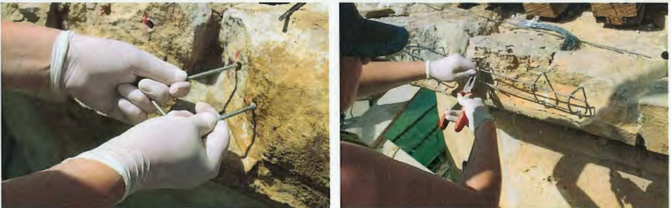
ზემოთფოტო კარნიზი. უჟანგავი ლითონის ანკერებით, არმირებისთვის განკუთვნილი კარნიზის მონტაჟის პროცესი.
