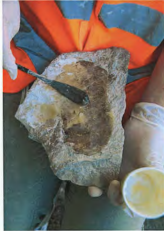
ზემოთ ფოტო. ცოკოლი, ფრაგმენტირებული ქვის განცალკევება და ელასტიური ეპოქსიდური რეზინით დამუშავების პროცესი.
