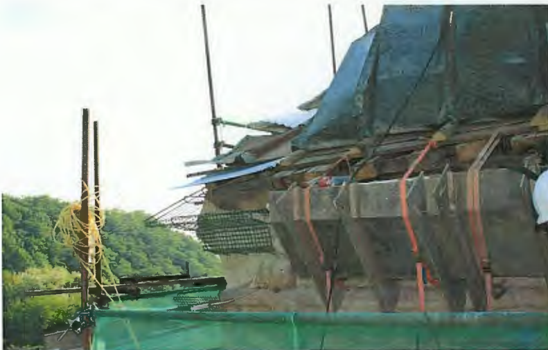
მარცხნივ/ზემოთ: ფოტო. სამხრეთ ფასადი. დაიანებული კარნიზის ქვა. მარჯვნივ/ზემოთ: ფოტო. სამხრეთ ფასადი. კარნიზი. ფოტო რეკონსტრუქციის შემდეგ.
