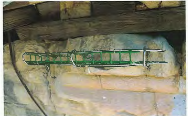
ზემოთ, მარცხნივ: ფოტო. ჩრდილოეთ ფასადი. დაზიანებული კარნიზის ქვა ზემოთ, მარჯვნივ: ფოტო. ჩრდილოეთ ფასადი. კარნიზი. არმირებისთვის განკუთვნილი კარკასი.
