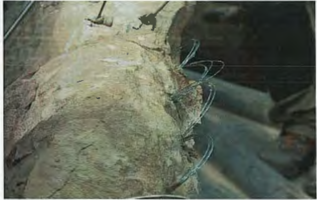
ზემოთფოტო კარნიზი.უჟანგავი ლითონის ანკერებით, არმირებისთვის განკუთვნილი კარნიზის მონტაჟის პროცესი.
