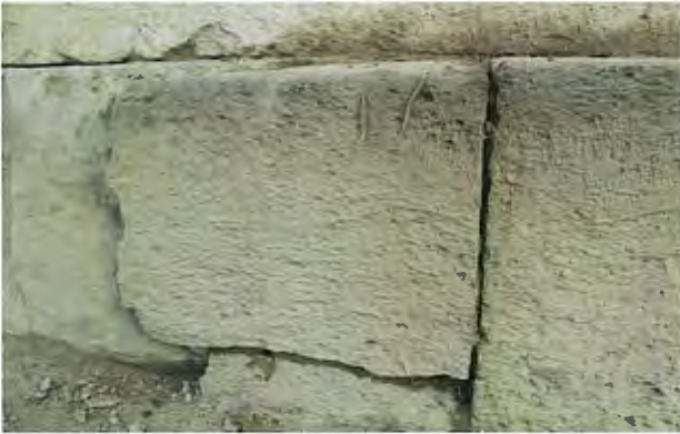
მარცხნივ/ზემოთ: ფოტო. დაზიანებული ცოკოლის ქვა. სარესტავრაციო პროცესამდე. მარჯვნივ/ზემოთ: ფოტო. კონსერვირებული ცოკოლის ქვა. სარესტავრაციო პოცესების შენდეგ.
