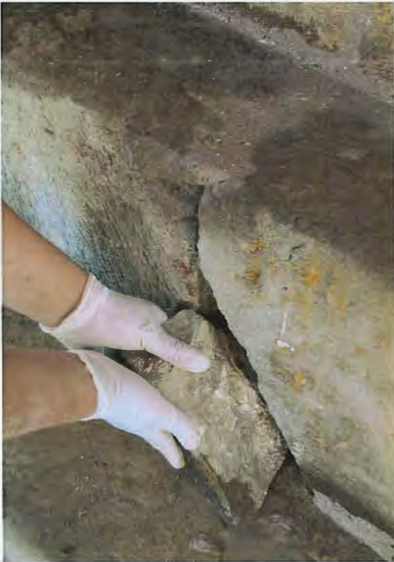
ზემოთ ფოტო. ცოკოლი, ფრაგმენტირებული ქვის განცალკევება და ელასტიური ეპოქსიდური რეზინით დამუშავების პროცესი.
