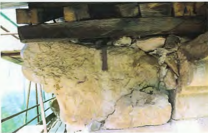
მარცხნივ/ზემოთა ფლტო. სამხრეთ ფასადი. დაიანებული კარნიზის ქვა. მარჯვნივ/ზემოთა ფლტო. სამხრეთ ფასადი.კარნიზი. ფლტო რეკონსტრუქციის შემდეგ.
