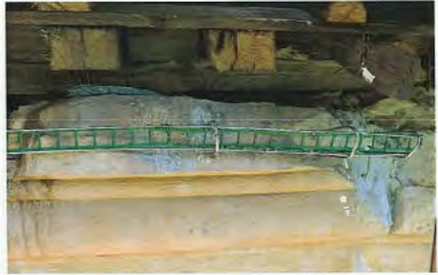
ზემოთ, მარჯვნივ: ფოტო. ჩრდილოეთ ფასადი. დაზიანებული კარნიზის ქვა ზემოთ, მარჯვნივ: ფოტო. ჩრდილოეთ ფასადი. კარნიზი. არმირებისთვის განკუთვნილი კარკასი.
