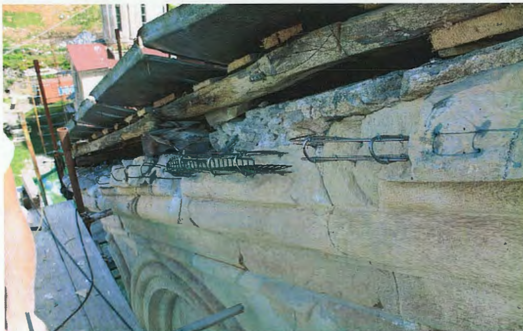
მარცხნივ/ზემოთ ფოტო. ჩრდილოეთ ფასადი. კარნიზი. არმირებული კარკასის მონტაჟის პროცესი.
