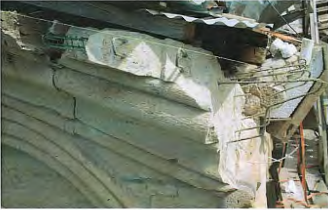
მარცხნივ/ზემოთ: ფოტო. სამხრეთ ფასადი. დაიანებული კარნიზის ქვა. მარჯვნივ/ზემოთ: ფოტო. სამხრეთ ფასადი. კარნიზი. ფოტო რეკონსტრუქციის შემდეგ.
