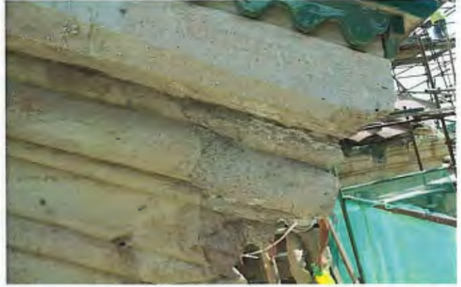
მარცხნივ/ზემოთ: ფოტო. სამხრეთ ფასადი. დაიანებული კარნიზის ქვა. მარჯვნივ/ზემოთ: ფოტო. სამხრეთ ფასადი. კარნიზი. ფოტო რეკონსტრუქციის შემდეგ.
