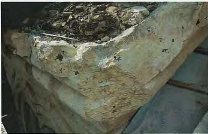
ზემოთ, მარცხნივ: ფოტო კარნიზი. დაზიანებული კარნიზის ქვა. საანკერე ხვრელებისთვის ადგილების მონიშვნის პროცესი. ზემოთ, მარჯვნივ: ფოტო კარნიზი. საანკერე ხვრელებისთვის ადგილების მონიშვნის პროცესი.
