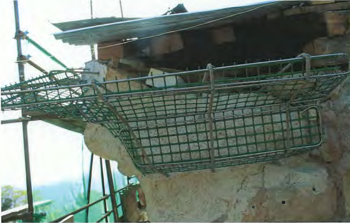
ზემოთ ფოტო. სამხრეთ ფასადი. კარნიზი. წინასწარ მომზადებულ საანკერე ხვრელებში, უჟანგავი ლითონის 8მმ-იანი არმირებისთვის განკუთვნილი კარკასის მონტაჟის პროცესი.
