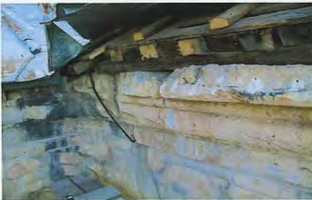
ზემოთ, მარცხნივ: ფოტო. ჩრდილოეთ ფასადი. დაზიანებული კარნიზის ქვა ზემოთ, მარჯვნივ: ფოტო. ჩრდილოეთ ფასადი. კარნიზი. არმირებისთვის განკუთვნილი კარკასი.
