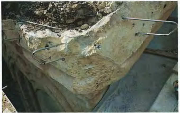
ზემოთ, მარცხნივ: ფოტო კარნიზი. დაზიანებული კარნიზის ქვა. საანკერე ხვრელებისთვის ადგილების მონიშვნის პროცესი. ზემოთ, მარჯვნივ: ფოტო კარნიზი. საანკერე ხვრელებისთვის ადგილების მონიშვნის პროცესი.
