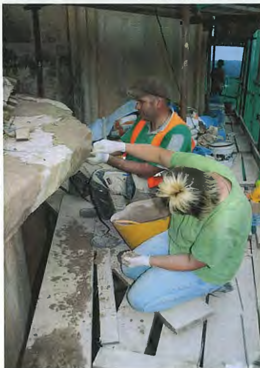
ზემოთაფოტო კარნიზი.არმირებული კრისხნარით რეკონსტრუქციის პროცესი.
