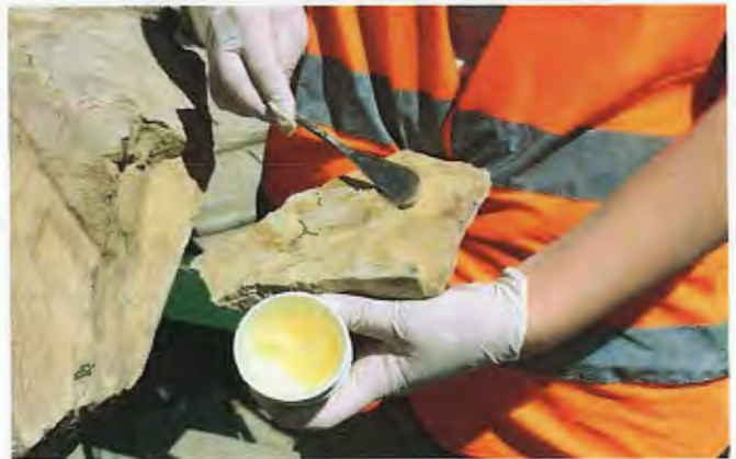
ზემოთ/ფოტო. კარნიზი. ქვის ფრაგმენტირებული დეტალების ეპოქსიდური რეზინით გაერთიანების პროცესი.
