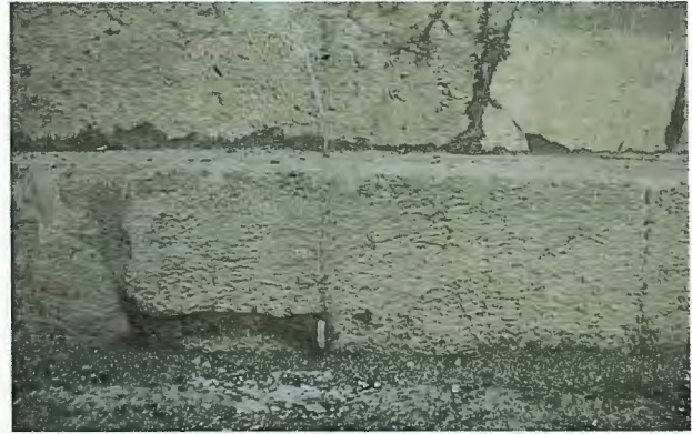
მარცხნივ/ზემოთ: ფოტო. დაზიანებული ცოკოლის ქვა. სარესტავრაციო პროცესამდე. მარჯვნივ/ზემოთ: ფოტო. კონსერვირებული ცოკოლის ქვა. სარესტავრაციო პოცესების შენდეგ.
