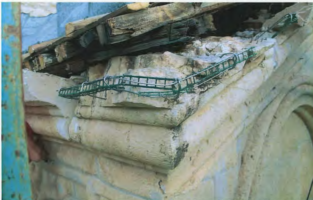
ზემოთ: ფოტო. დაზიანებული აკრნიზის ქვა. უჟანგავი ლითონის არმირებისთვის განკუთვნილი კარკასი.
