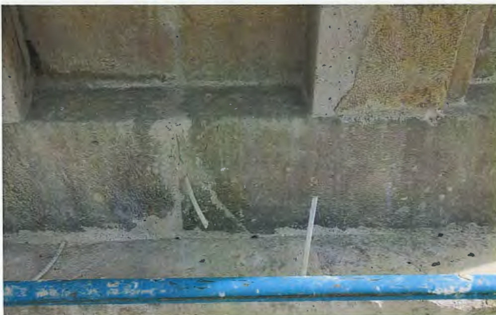
ზემოთ ფოტო. ცოკოლი, ფრაგმენტირებული ქვის უბანი. საბოლოო შედეგი.* *შენიშვნა- კონკრეტულ ადგილას დატოვებულია პლასტმასის საინექციო ტუბი.
