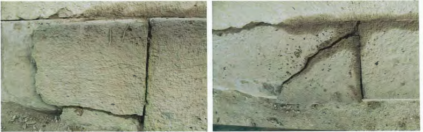
ზემოთ: ფოტო. ცოკოლის ქვის დაზიანებული დეტალი. წინ და ზედ ხედები.
