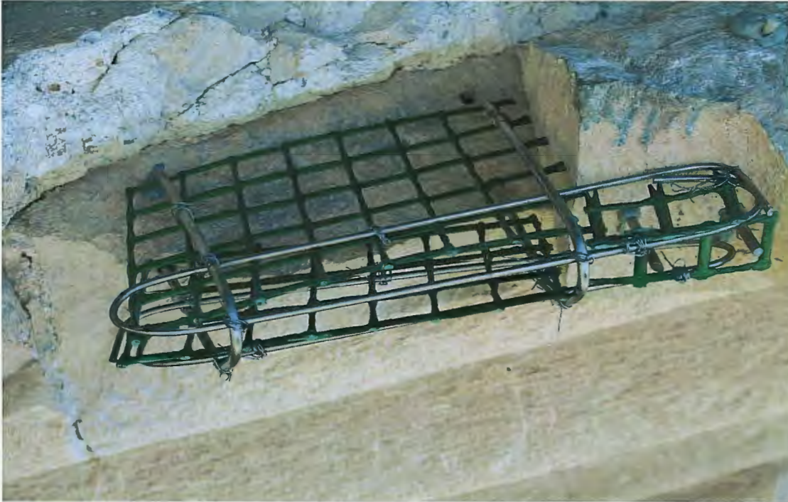
ზემოთ: ფოტო 6მმ სისქის უჟანგავი ლითონითა და მინაბოკოვანი საარმირებო ბადით არმირებული კარნიზის ქვა.დეტალი
