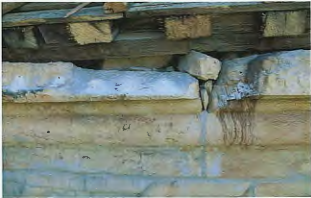
ზემოთ, მარჯვნივ: ფოტო. ჩრდილოეთ ფასადი. დაზიანებული კარნიზის ქვა ზემოთ, მარჯვნივ: ფოტო. ჩრდილოეთ ფასადი. კარნიზი. არმირებისთვის განკუთვნილი კარკასი.
