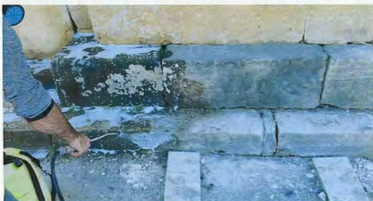
ზემოთ მარცხნივ: ფოტო. ცოკოლი. ბიოციდით დამუშავება ზემოთ მარჯვნივ: ფოტო. ცოკოლი. ბიოციდით დამუშავება.
