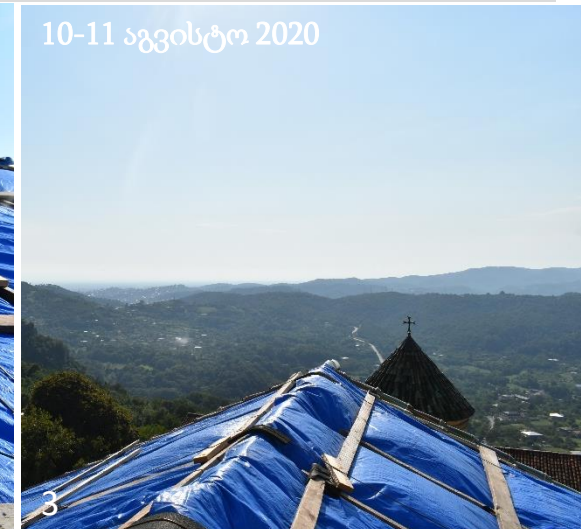
10-11 აგვისტოს ფოტოებზე (ზევით) მოცემულია დასავლეთი მკლავის ჩრდილოეთი ფერდი. ტრომპის კედელთან შეპირაპირების ადგილი დაფარულია/ ამოვსებულია საიზოლაციო ქაფით (1), ტენტი ჩამაგრებულია ხის ფიცრებით (2) ტენტი გადასულია ორივე ფერდზე (3).
