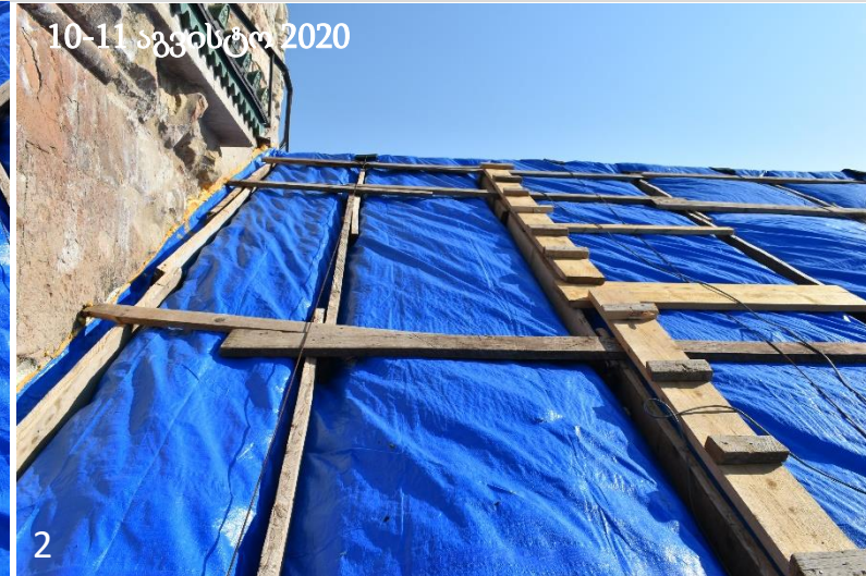
10-11 აგვისტოს ფოტოებზე (ზევით) მოცემულია დასავლეთი მკლავის ჩრდილოეთი ფერდი. ტრომპის კედელთან შეპირაპირების ადგილი დაფარულია/ ამოვსებულია საიზოლაციო ქაფით (1), ტენტი ჩამაგრებულია ხის ფიცრებით (2) ტენტი გადასულია ორივე ფერდზე (3).
