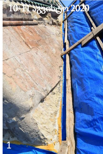
10-11 აგვისტოს ფოტოებზე (ზევით) მოცემულია დასავლეთი მკლავის ჩრდილოეთი ფერდი. ტრომპის კედელთან შეპირაპირების ადგილი დაფარულია/ ამოვსებულია საიზოლაციო ქაფით (1), ტენტი ჩამაგრებულია ხის ფიცრებით (2) ტენტი გადასულია ორივე ფერდზე (3).
