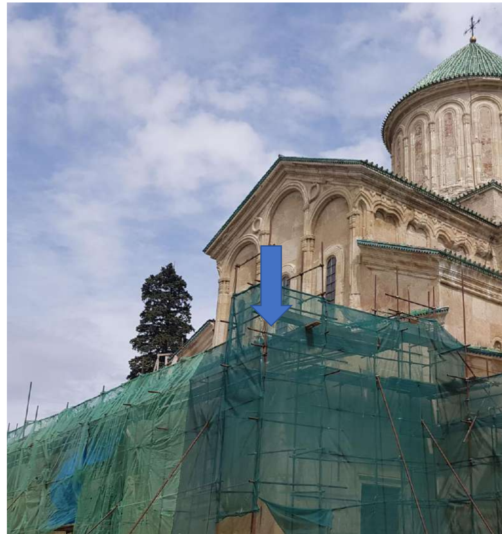
ნართექსი მთლიანად ჩასმულია ხარაჩოში, კრამიტის გადახურვა სამხრეთ ნაწილში დასრულებული ჩანს.
