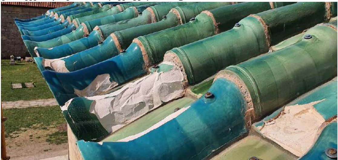
სურ. 1. დაზიანებული კრამიტის ფრაგმენტი
