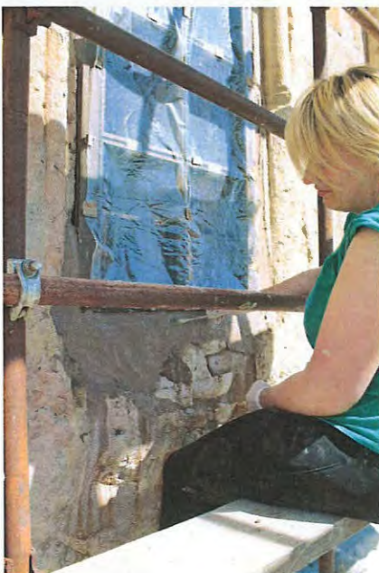
ზემოთ,მარცხნივ: დაზიანებული ქვის ღიობის კირხსნარით არმირების პროცესი ზემოთ,მარჯვნივ: არმირებული ქვის ღიობი.
