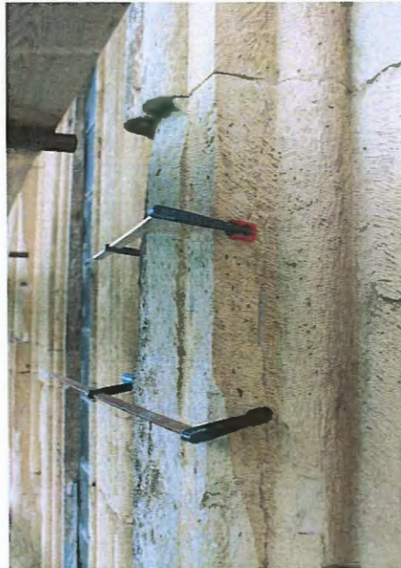
ზემოთ მარცხნივ: ფოტო. ფრაგმენტირებული ქვის გაერთიანება. ფრაგმენტის ავთვენტურ ადგიალს დაბრუნების პროცესი. ზემოთ მარჯვნივ: ფოტო. ფრაგმენტირებული ქვის გაერთიანება. გაერთიანებული ფრაგმენტი, დროებითი ჟგუტებით.
