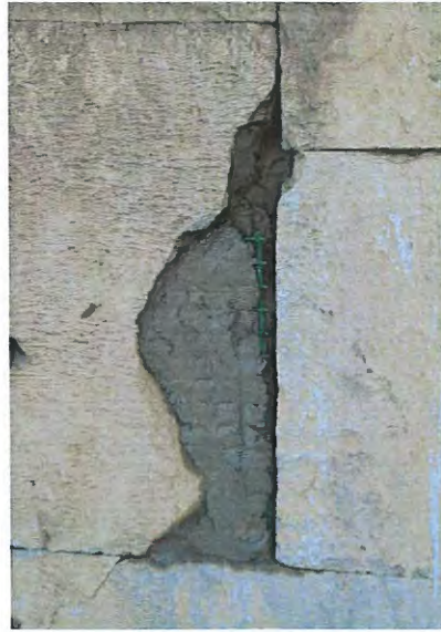
მარცხნივ/ზემოთ ფოტო. დაზიანებული საპირე წყობის. სარესტავრაციო პროცესამდე. მარჯვნივ/ზემოთ ფოტო. კირხსნარით არმირების პროცესი.
