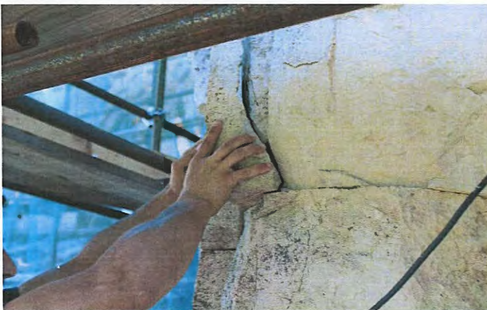
ზემოთ : ფოტო. ფრაგმენტირებული ქვის გაერთიანება. ფრაგმენტის ავოვენტურ ადგიალს დაბრუნების პროცესი.
