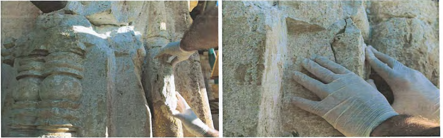
ზემოთ : ფოტო. ფრაგმენტირებული ქვის გაერთიანება. ფრაგმენტის ავთენტურ ადგიალს დაბრუნების პროცესი.
