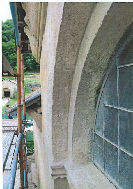
მარცხნივ/ზემოთ ფოტო. ჩრდილოეთ ეკვდერის საპირე წყობის დაზიანებული ქვა. სარესტავრაციო პროცესამდე. მარჯვნივ/ზემოთ ფოტო. ჩრდილოეთ ეკვდერის საპირე წყობის დაზიანებული ქვა. სარესტავრაციო პოცესების შემდგომ
