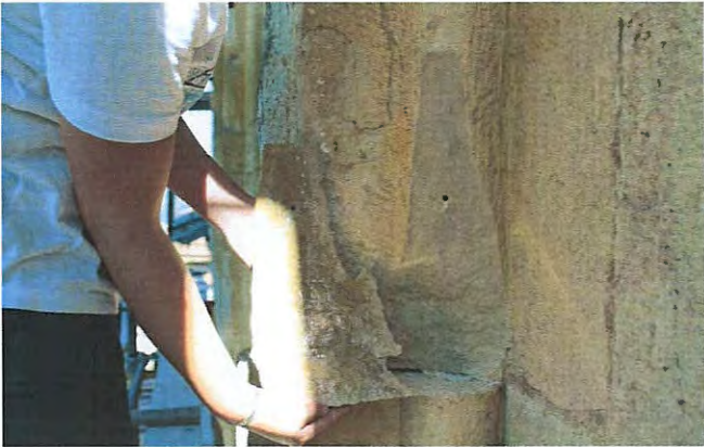
ზემოთ : ფოტო. ფრაგმენტირებული ქვის გაერთიანება. ფრაგმენტის ავთვეენტურ ადგიალს დაბრუნების პროცესი.
