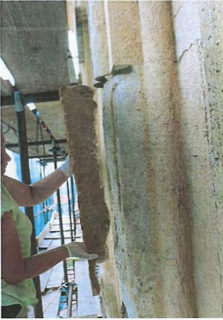
ზემოთ მარცხნივ: ფოტო. ფრაგმენტირებული ქვის გაერთიანება. ფრაგმენტის ავთვენტურ ადგიალს დაბრუნების პროცესი. ზემოთ მარჯვნივ: ფოტო. ფრაგმენტირებული ქვის გაერთიანება. გაერთიანებული ფრაგმენტი, დროებითი ჟგუტებით.
