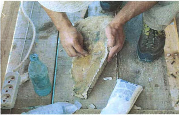
ზემოთ : ფოტო. ფრაგმენტირებული ქვის გაერთიანება. ფრაგმენტის აცეტონითა და ეპოქსიდური რეზინით დამუშავების პროცესი.
