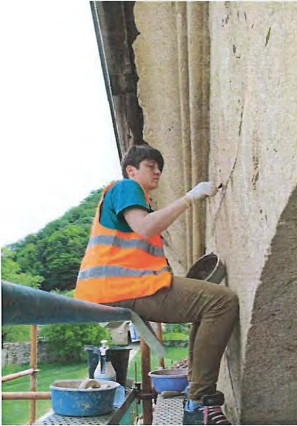
მარცხნივ/ზემოთ ფოტო. ჩრდილოეთ ეკვდერის საპირე წყობის დაზიანებული ქვის რესტავრაციის პროცესი. მარჯვნივ/ზემოთ ფოტო. ჩრდილოეთ ეკვდერის საპირე წყობის დაზიანებული ქვა. სარესტავრაციო პოცესების შემდგომ
