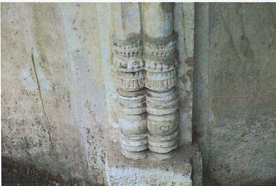
ზემოთფოტო.საპირე წყობის ნაკლული ადგილების ხირსხნართ რეკონსტრუქციული დეტალი
