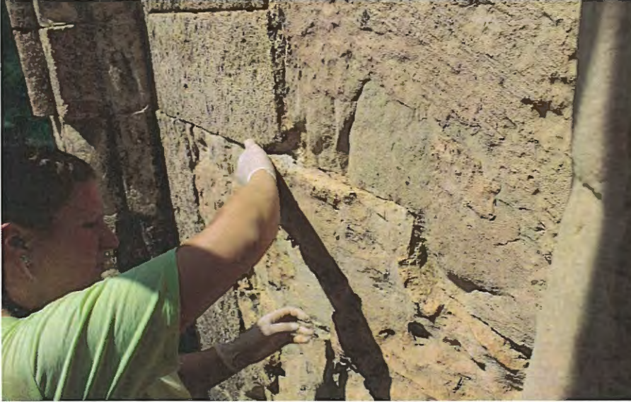
ზემოთ: ფოტო. სამხრეთ ფასადი.ფრაგმენტირებული ქვის ზედაპირი.გაერთიანების პროცესი
