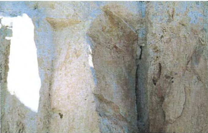
მარცხნივ/ზემოთ: ფოტო. დაზიანებული ფასადის ქვა. მარჯვნივ/ზემოთ: ფოტო. კირხსნარით რეკონსტრუქციის პროცესი.
