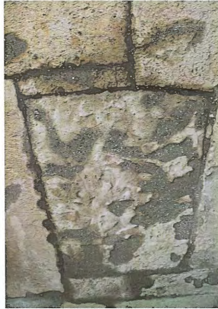
მარცხნივ/ზემოთ ფოტო. ჩრდილოეთ ეკვდერის საპირე წყობის დაზიანებული ქვის რესტავრაციის პროცესი. მარჯვნივ/ზემოთ ფოტო. ჩრდილოეთ ეკვდერის საპირე წყობის დაზიანებული ქვა. სარესტავრაციო პოცესების შემდგომ
