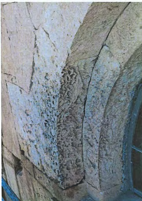
მარცხნივ/ზემოთ ფოტო. ჩრდილოეთ ეკვდერის საპირე წყობის დაზიანებული ქვა. სარესტავრაციო პროცესამდე. მარჯვნივ/ზემოთ ფოტო. ჩრდილოეთ ეკვდერის საპირე წყობის დაზიანებული ქვა. სარესტავრაციო პოცესების შემდგომ
