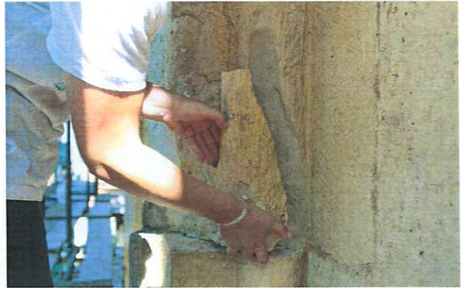
ზემოთ : ფოტო. ფრაგმენტირებული ქვის გაერთიანება. ფრაგმენტის ავთვეენტურ ადგიალს დაბრუნების პროცესი.
