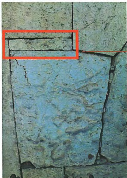
მარცხნივ/ზემოთ ფოტო. ჩრდილოეთ ეკვდერის საპირე წყობის დაზიანებული ქვა. კონტექსტი. მარჯვნივ/ზემოთ ფოტო. ჩრდილოეთ ეკვდერის საპირე წყობის დაზიანებული ქვა. დეტალი.
