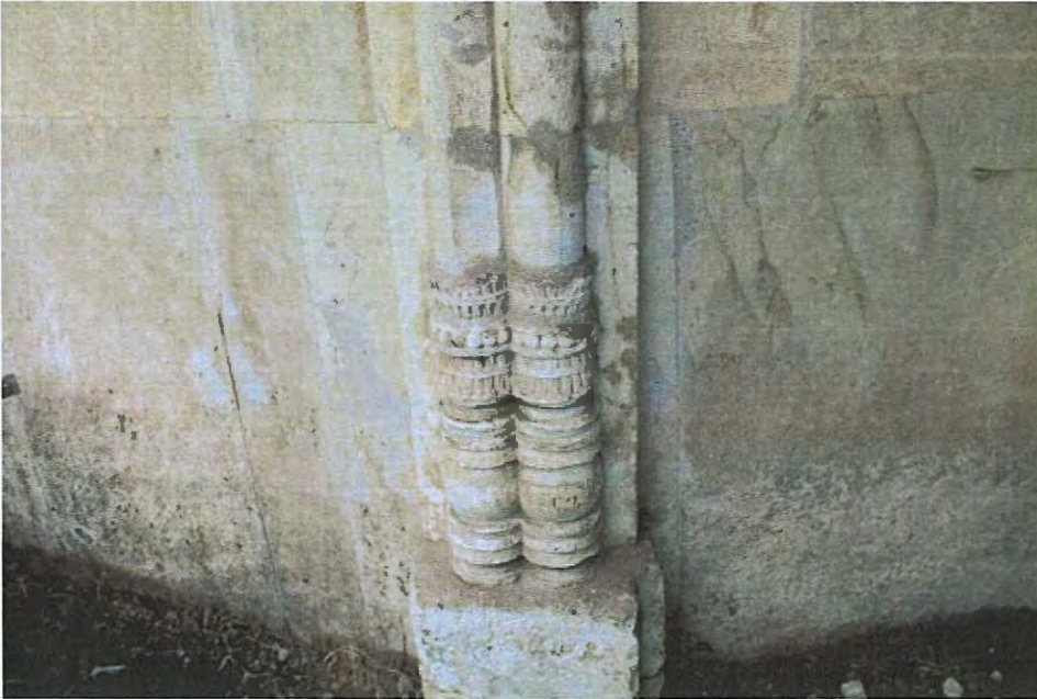
ზემოთფოტო.საპირე წყობის ნაკლული ადგილების ხირსხნართ რეკონსტრუქციული დეტალი
