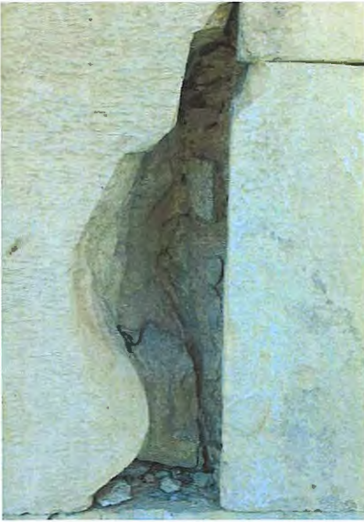
მარცხნივ/ზემოთ ფოტო. დაზიანებული საპირე წყობის. სარესტავრაციო პროცესამდე. მარჯვნივ/ზემოთ ფოტო. კირხსნარით არმირების პროცესი.
