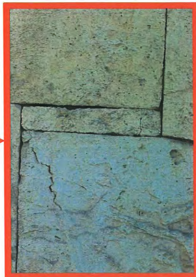
მარცხნივ/ზემოთ ფოტო. ჩრდილოეთ ეკვდერის საპირე წყობის დაზიანებული ქვა. კონტექსტი. მარჯვნივ/ზემოთ ფოტო. ჩრდილოეთ ეკვდერის საპირე წყობის დაზიანებული ქვა. დეტალი.
