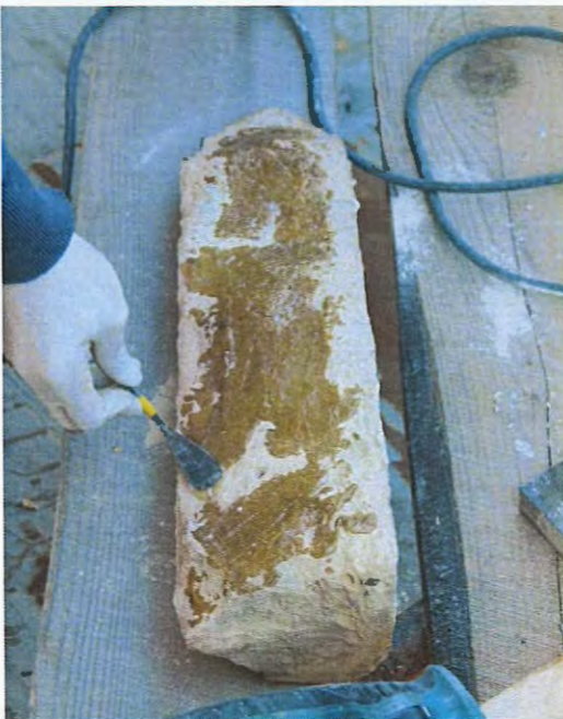
ზემოთ, მარცხნივ: ფოტო. დაზიანებული ორნამენტული ნაწილი ზე ეპოქსიდური რეზინის დატანის პროცესი. ზემოთ, მარჯვნივ: ქვის ზედაპირზე ეპოქსიდური რეზინის დატანის პროცესი.
