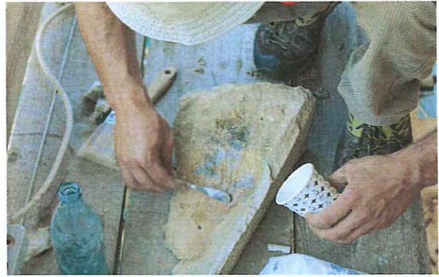
ზემოთ : ფოტო. ფრაგმენტირებული ქვის გაერთიანება. ფრაგმენტის აცეტონითა და ეპოქსიდური რეზინით დამუშავების პროცესი.
