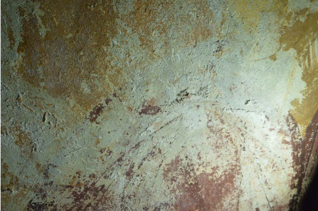
14. დასავლეთი მკლავის კამარის სამხრეთი ფერდი, მდგომარეობა სრული კონსერვაციის შემდგომ. გამომარილება, ნალესობის გაფხვიერება და განშრევა
