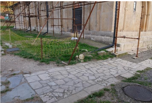
Figure 7: view of downpipes d17 , d16 , d15 and d14
