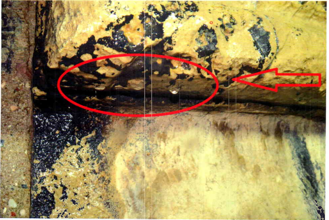
დაფიქსირდა წყლის ღარის დაბოლოება კედელთან, ზედა მხრიდან და მასთან არსებული სველი კედელი. (იხ. სურ.66-68)
