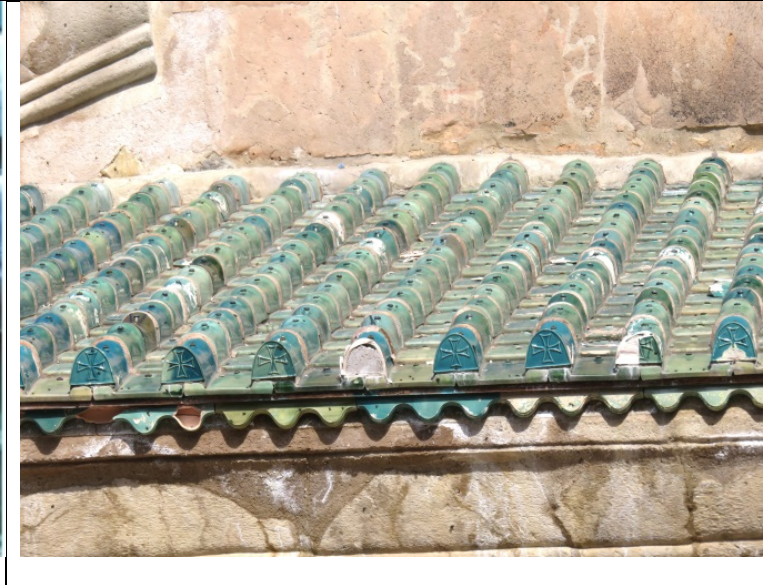
Fig.6 – Roofing tile damages / გადახურვა და დაზიანებები
