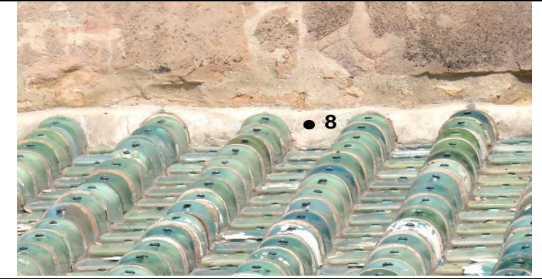
Fig.8 – Sealing with mortar vertical structure/covering ვერტიკალურ სტრუქტურასთან დუღაბით ამოვსება
