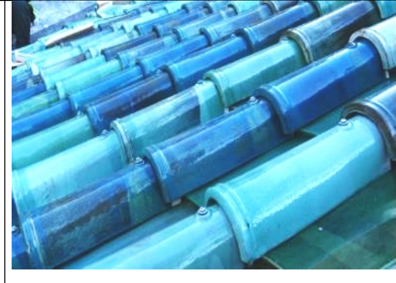
Fig.5 – Installed ceramic tiles/ დამონტაჟებული კრამიტი
