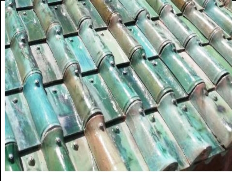
Fig.4 – Installed ceramic tiles/დამონტაჟებული კრამიტი
