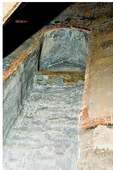
სურათი 6. ნოვგოროდი – ღვთისმშობლის ტაძარი წმ. ანტონის მონასტერში: ფანჯრის ღიობების ამოქნება
