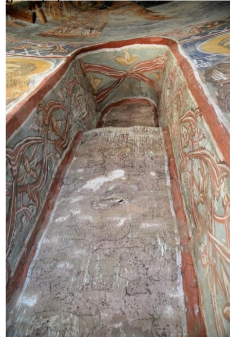
სურათი 8. გუმბათის ცილინდრული ნაწილის ამოშენებული ფანჯრის ღიობები
