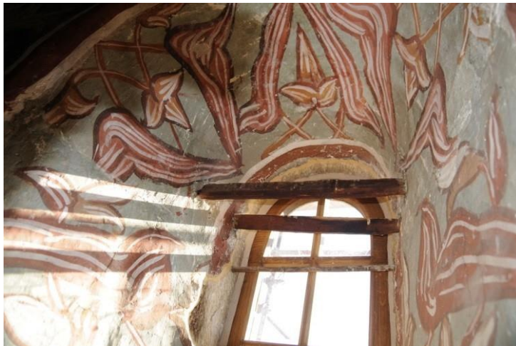
სურათი 7. ხის ანკერული რიგელები ჯერ კიდევ შემონახულია გუმბათის ცილინდრის ფანჯრის ღიობებში
