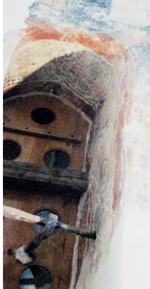
სურათი 2,3. ნოვგოროდი – ღვთისმშობლის ტაძარი წმ. ანტონის მონასტერში: შემონახული შუა საუკუნეების ფანჯარა, და აღდგენილი მერქნის ფანჯარა–რაფა
