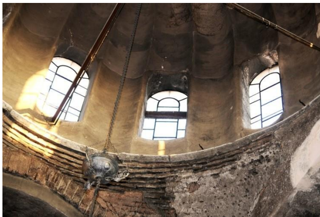
სურათი 1. ხის ანკერული რიგელები ღვთისმშობლის კოსმოსოტიერას ეკლესიის ფანჯრებზე, საბერძნეთი
