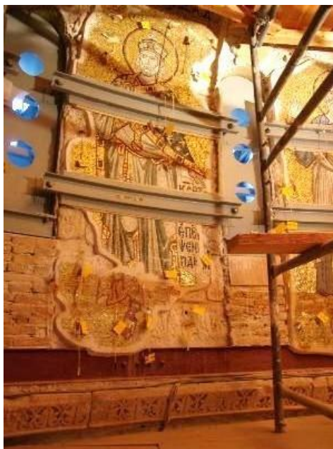
სურათი 12. ფოლადის ელემენტები ორ დონეზე ქვის წყობის ხიმინჯების შემოსაზღვრისთვის. ყურადღება მიაქცეით I – კოჭს, ქვედა ნაწილში.
