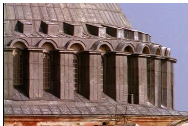
სურათი 9, 10. წმ. სოფია, კონსტანტინოპოლი – ფანჯრებს შორის არსებული ხიმინჯების გამაგრება, თავდაპირველი გუმბათი 559 წ. ჩამოშლის შემდგომ.
