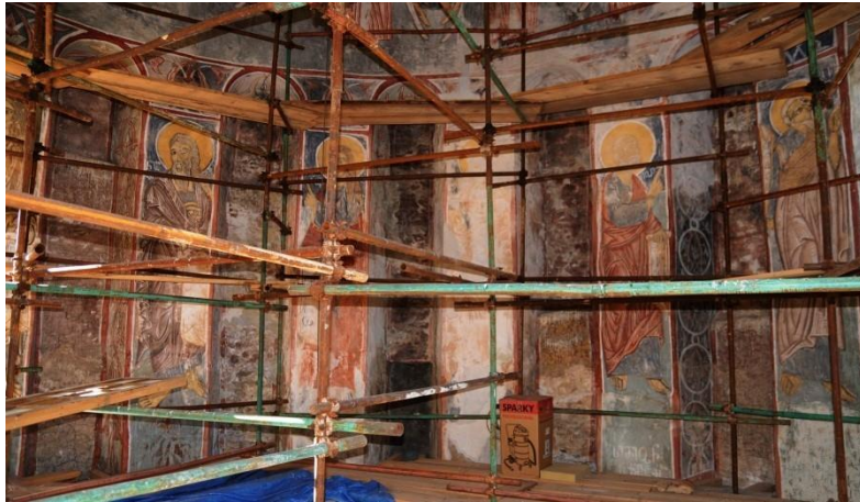
სურათი 68. გუმბათის ცილინდრის სამხრეთ-დასავლეთი ფანჯრები, რომელიც დახურულია აგურების/ქვების წყობით კირდულაბში
