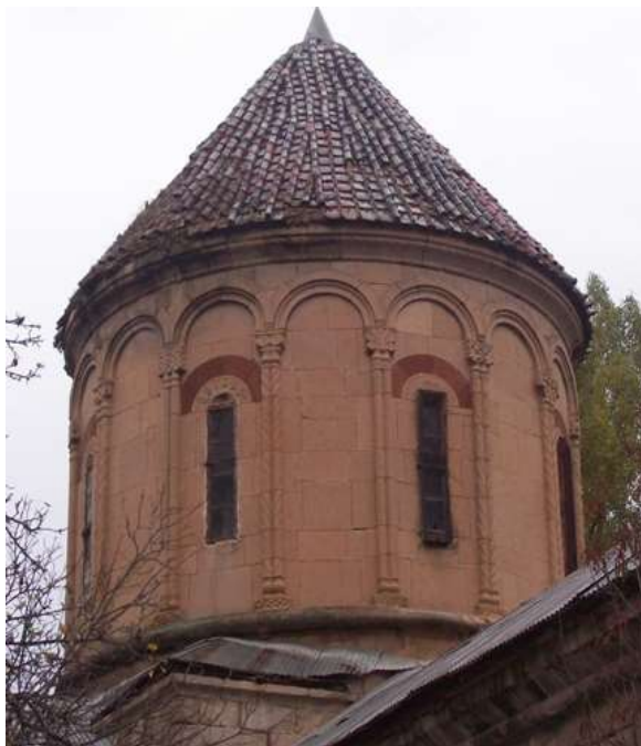
სურ.11. ხახულის ეკლესია ტაო-კლარჯეთი (თურქეთი). გუმბათი მოჭიქული კრამიტის საბურველით
