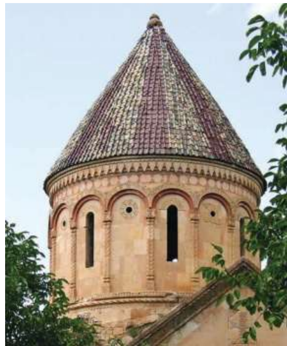
სურ.12. იშხნის ეკლესია ტაო-კლარჯეთი (თურქეთი). გუმბათი მოჭიქული კრამიტის საბურველით
