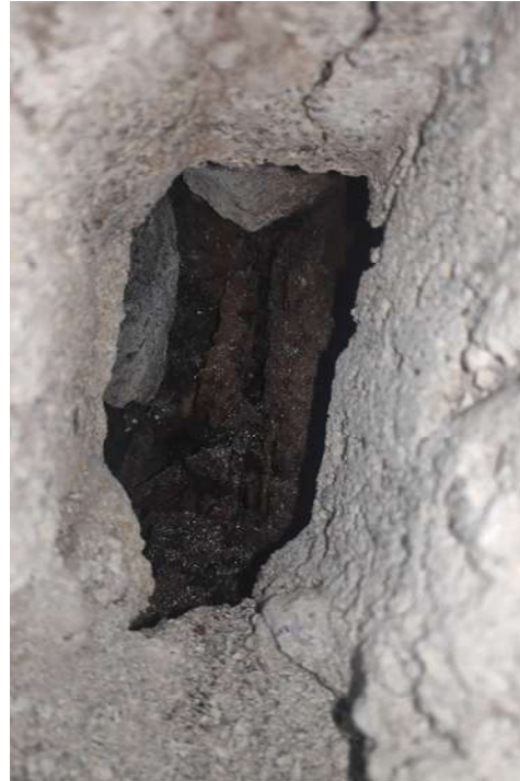
სურ. 51 გუმბათის ქვით აგებულ ადრეულ კონუსზე არსებული ლიობი, საიდანაც მოჩანს ხის ძელები (ფოტო-2022წ.)
