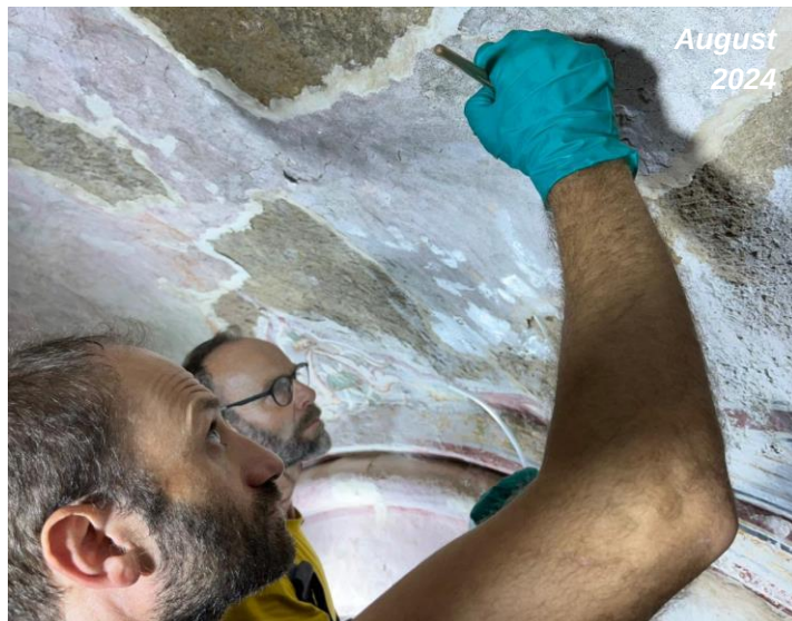
ზემოთ: საფუძველს მოწყვეტილი ნაღესობის ზედაპირული გამაგრება შექცევადი მასალით
